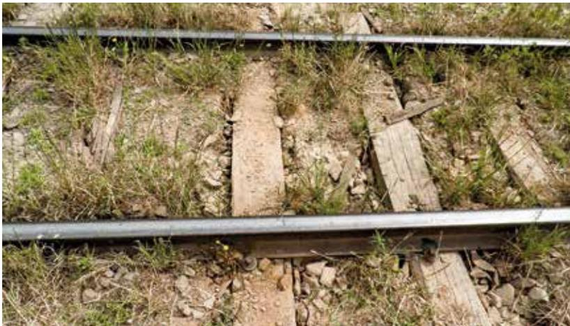
DORMENTES DE MADEIRA COM O LASTRO CONTAMINADO – FIXAÇÃO RÍGIDA COM *TIREFOND* SEM PLACA DE APOIO - RUMO MALHA SUL – RS
