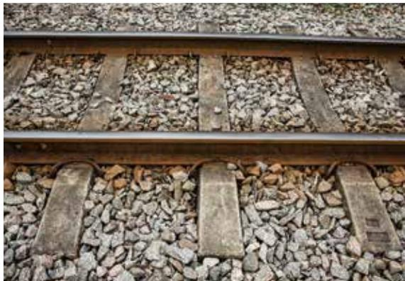
O dormente de concreto consiste em um bloco, ou 2 blocos, de concreto armado, protendido ou não.
