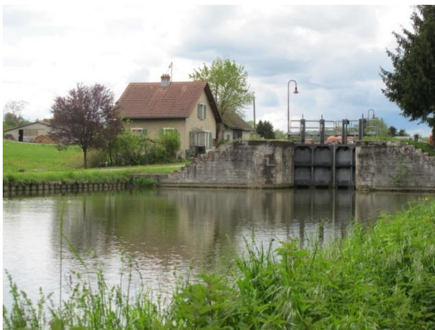
Eclusa gabarito freycinet nivelada ao nível d'água de jusante. Canal antigo do Reno ao Ródano. França. Foto de Venâncio Neiva, 2012.
