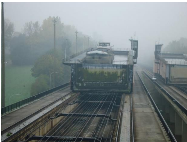
Tanques do Plano Inclinado de Ronquiére. Bélgica. Foto de Antônio Carlos Guimarães Neto, 2011.
