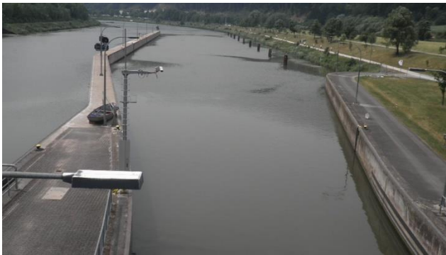
Acesso à eclusa de Riedenburg onde se destacam o muro guia a esquerda e as estacas guias a direita. Alemanha. Foto de Sílvio dos Santos, 2010.
