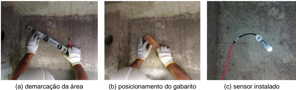
Figura 2 - Processo de instalação dos sensores WC.
