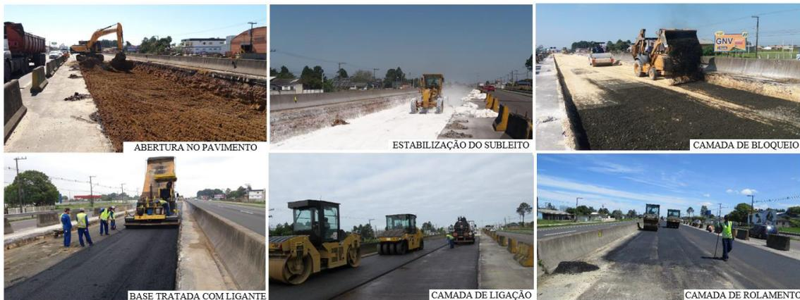
Figura 4. Etapas de execução do pavimento para sistema WIM
