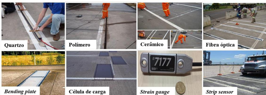
Figura 2. Tipos de sensores instalados em rodovias.
