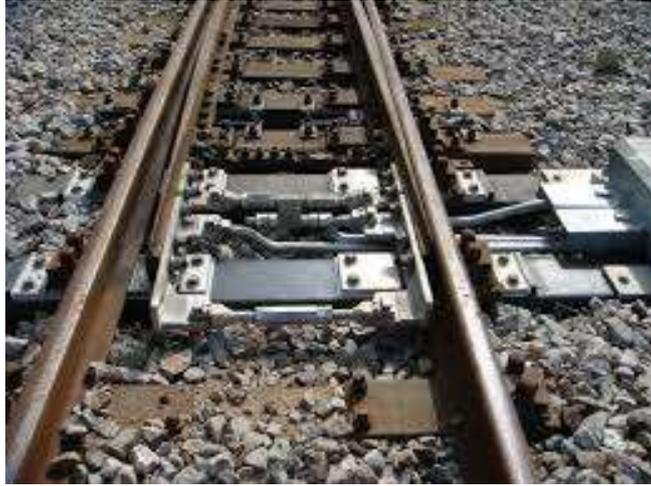
Figura 2.87. AMV (Aparelho de mudança de via) Elétrico
