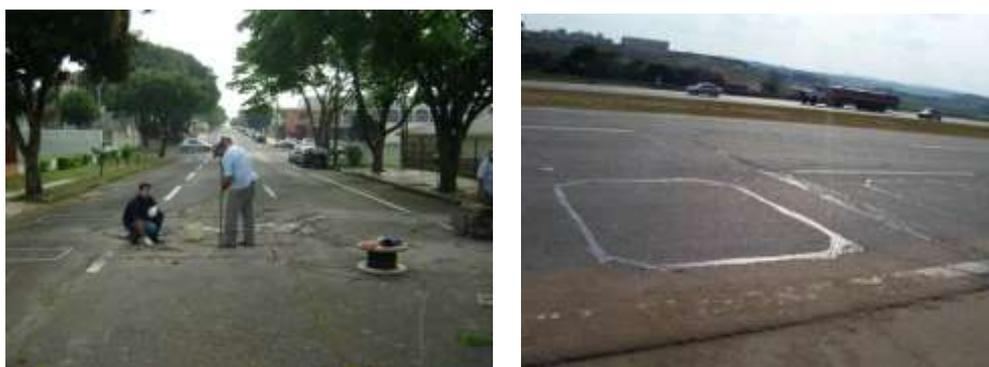
Figura 3.20. Imagem de instalação de um laço indutivo e de um laço instalado
