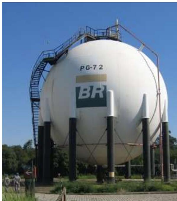
Figura 6.43. Esferas de armazenamento de gás em alta pressão
