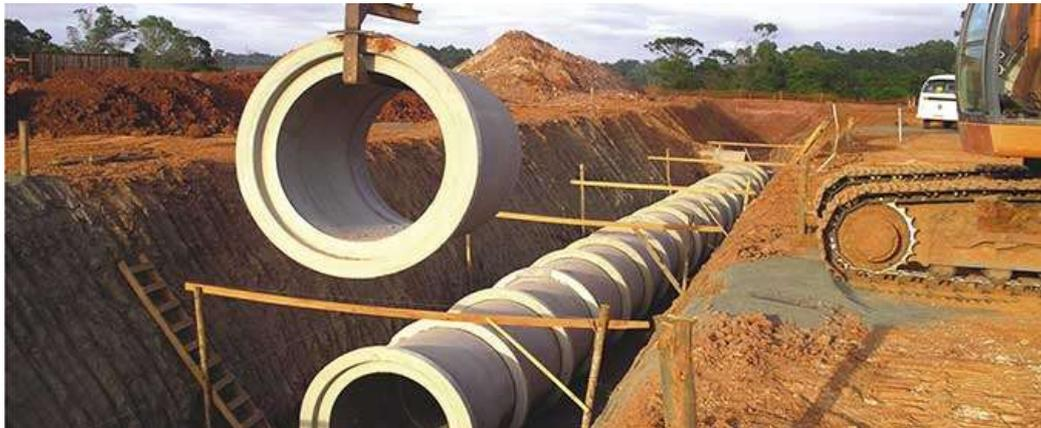
Figura 2.121. Dutos de concreto para rede Pluvial e Esgoto Sanitário
