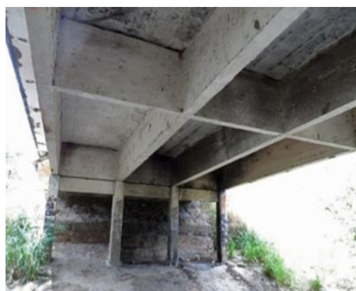
(b) Tabuleiro da ponte
