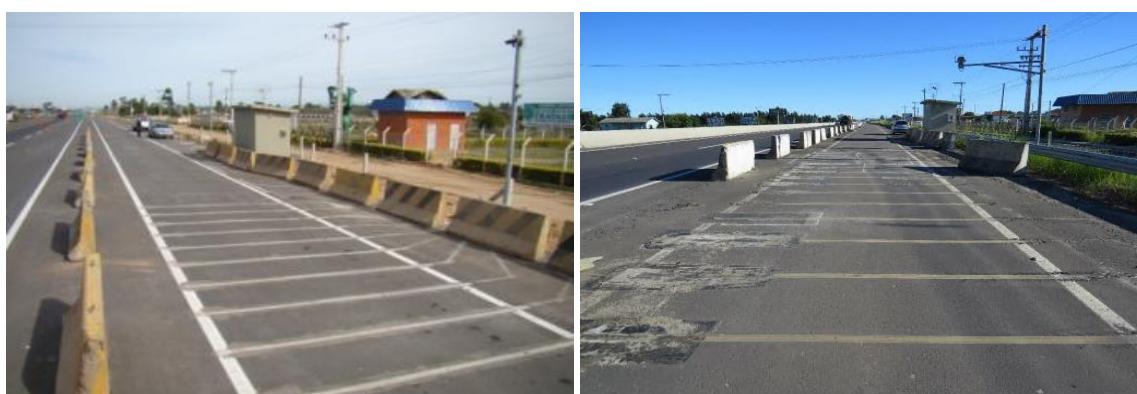
a) Após a instalação dos sensores HS-WIM
