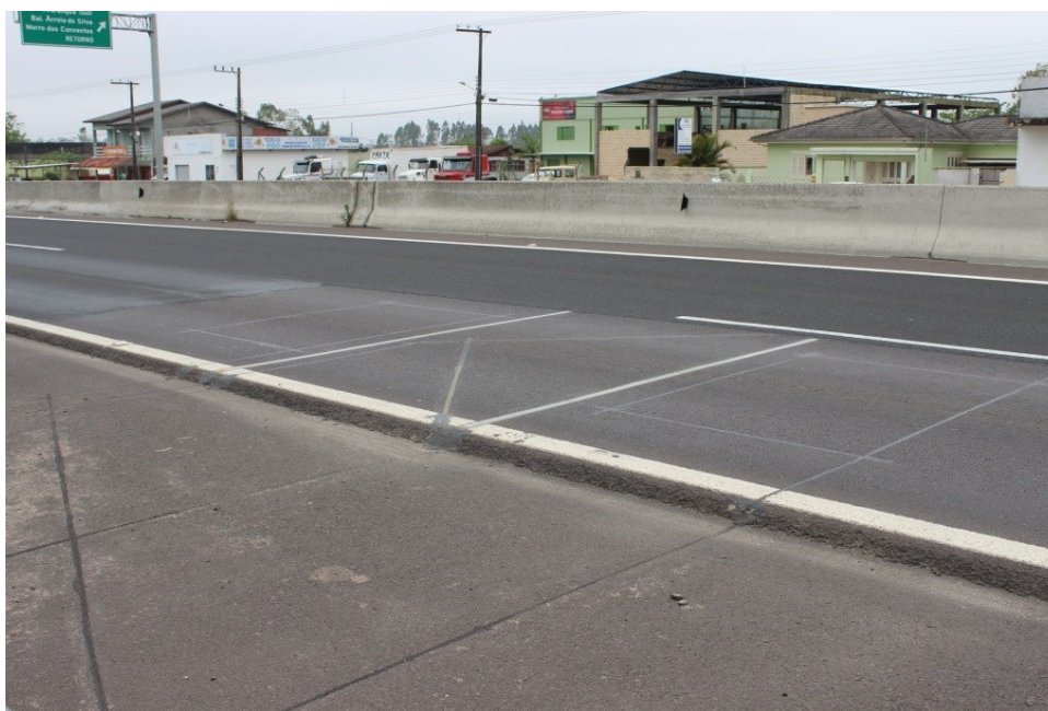
Figura 4: Sensores do sistema HS-WIM implantado na rodovia BR-101.
