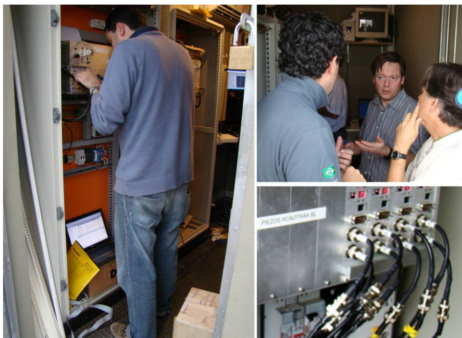
Figura 12 – Técnicos ECM e instalação de atenuadores de sinal.
