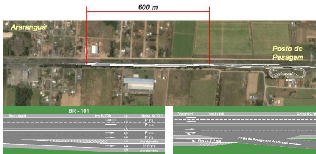
Figura 1 – Vista geral do local de instalação dos sensores de pesagem em movimento.
