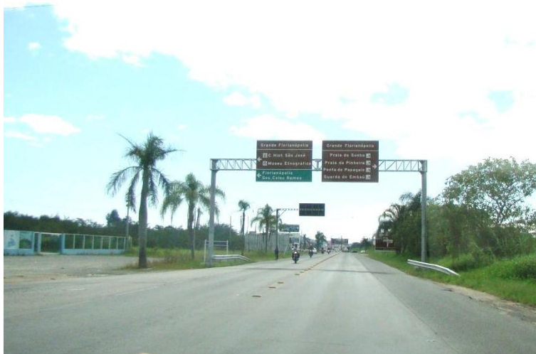
Figura 42 Pórtico com placas de indicação na aproximação da BR-282
