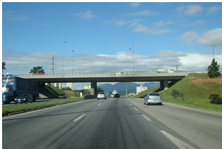
Figura 79 Marcas de frenagem no pavimento
