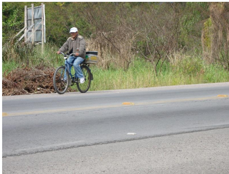
Figura 57 Ciclista trafegando no acostamento da BR-282 e desgaste de sinalização horizontal
