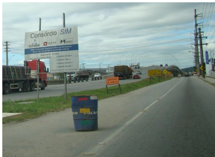
Figura 35 Identificação do início das obras no km 216,5
