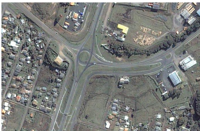
Figura 7 Imagem aérea da interseção entre BR-282 e BR-116
