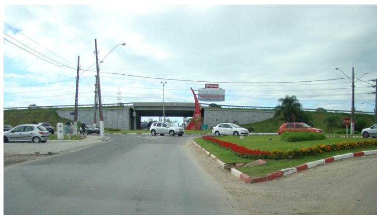
Figura 49 Ausência de sinalização horizontal e vertical – não preferencial
