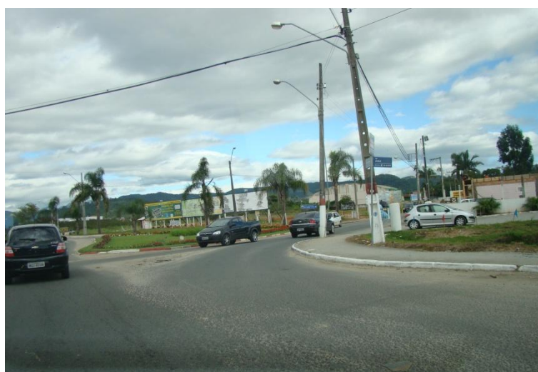
Figura 45 Ausência de sinalização horizontal na interseção
