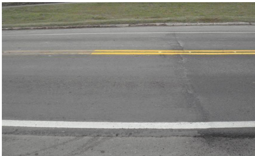
Figura 18 Trecho da BR-116 com sinais de recuperação
