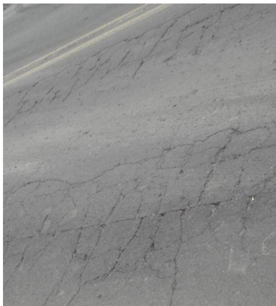
Figura 19 Trincas interligadas
