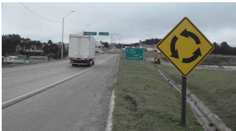
Figura 15 Sinalização de advertência A-12 - interseção em círculo (BR-116)
