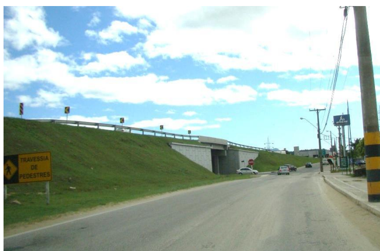
Figura 41 Placa de indicação na via marginal da BR-101 – Travessia de Pedestres
