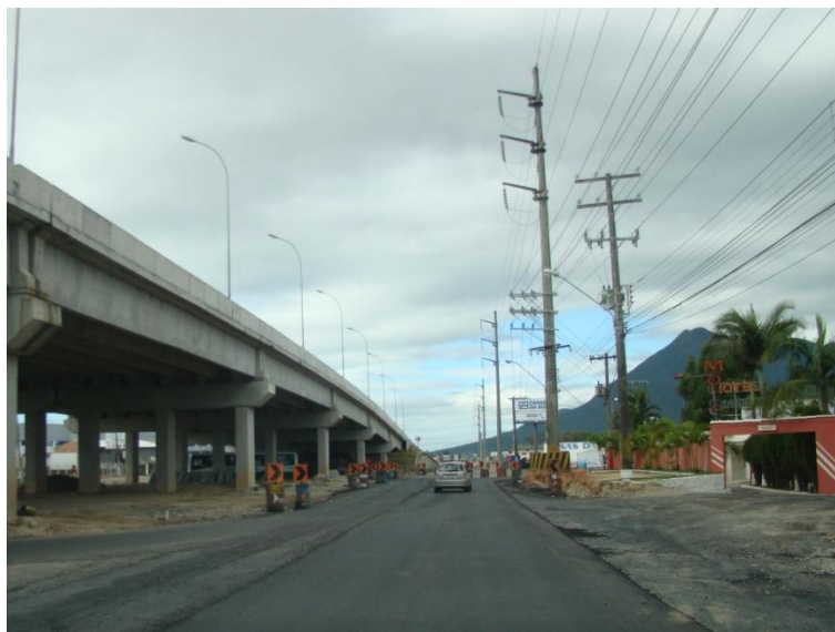
Figura 36 Trecho em obras no km 216,5
