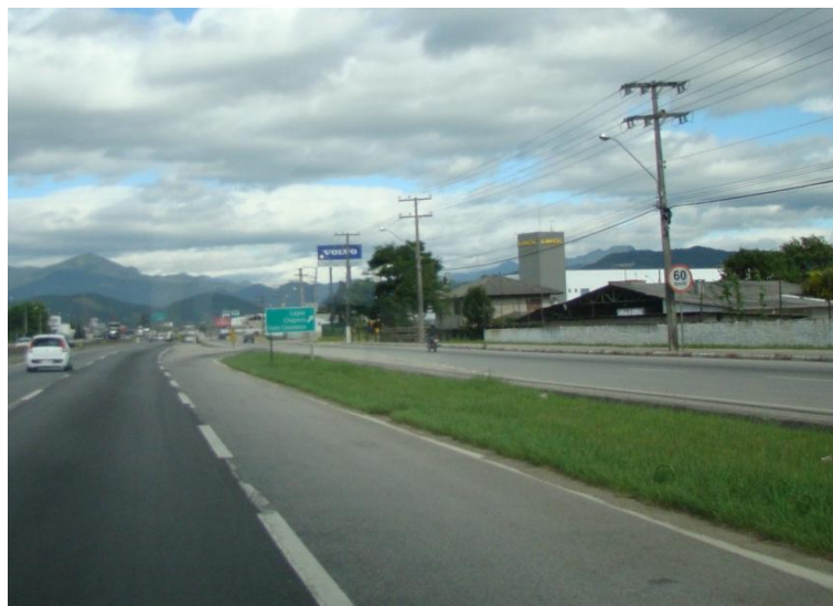
Figura 31 Sinalização vertical R-19 na via marginal da BR-101
