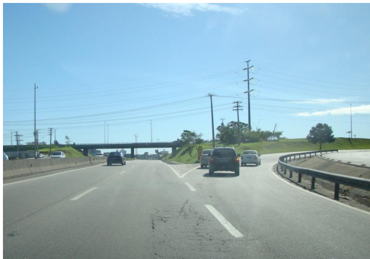
Figura 81 Trincas
