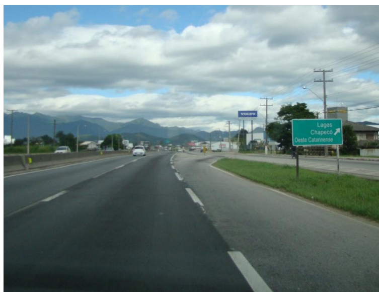
Figura 37 Acesso 1 à interseção de Palhoça
