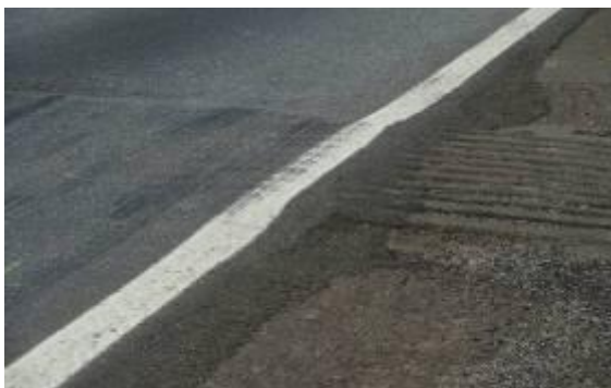
Figura 65. Recapeamento de pavimento sem retirada de sonorizador
