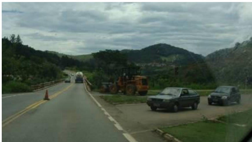
Figura 68. Acesso sobre obra de arte
