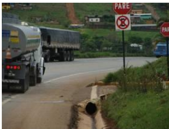
Figura 60. Acesso a estabelecimento comercial com sinalização própria do estabelecimento
