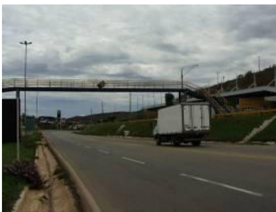
Figura 62. Passarela em frente a terminal rodoviário
