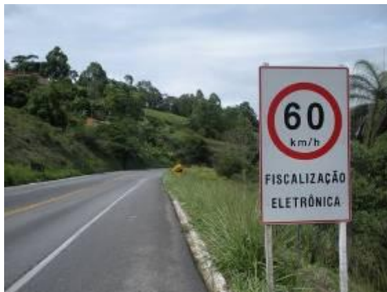
Figura 46. Sinalização composta - Fiscalização eletrônica/ regulamentação de velocidade
