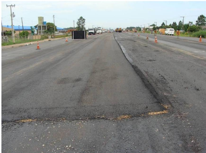
Figura 221 – Recapeamento pista existente.
