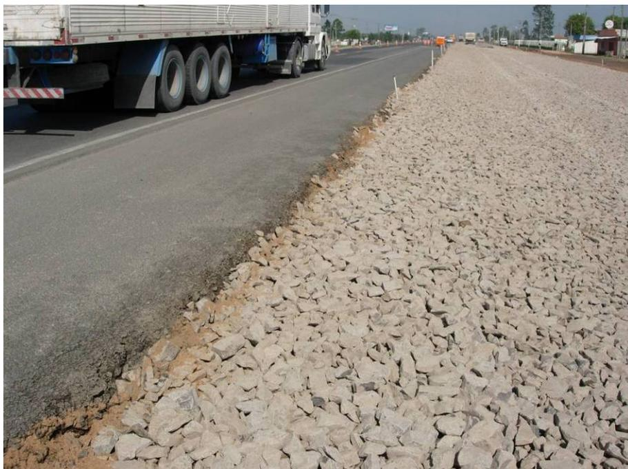
Figura 78 – Detalhe do encontro entre pista e acostamento.
