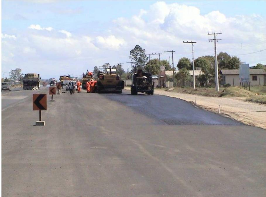
Figura 147 – Segmento final de espalhamento e compactação.
