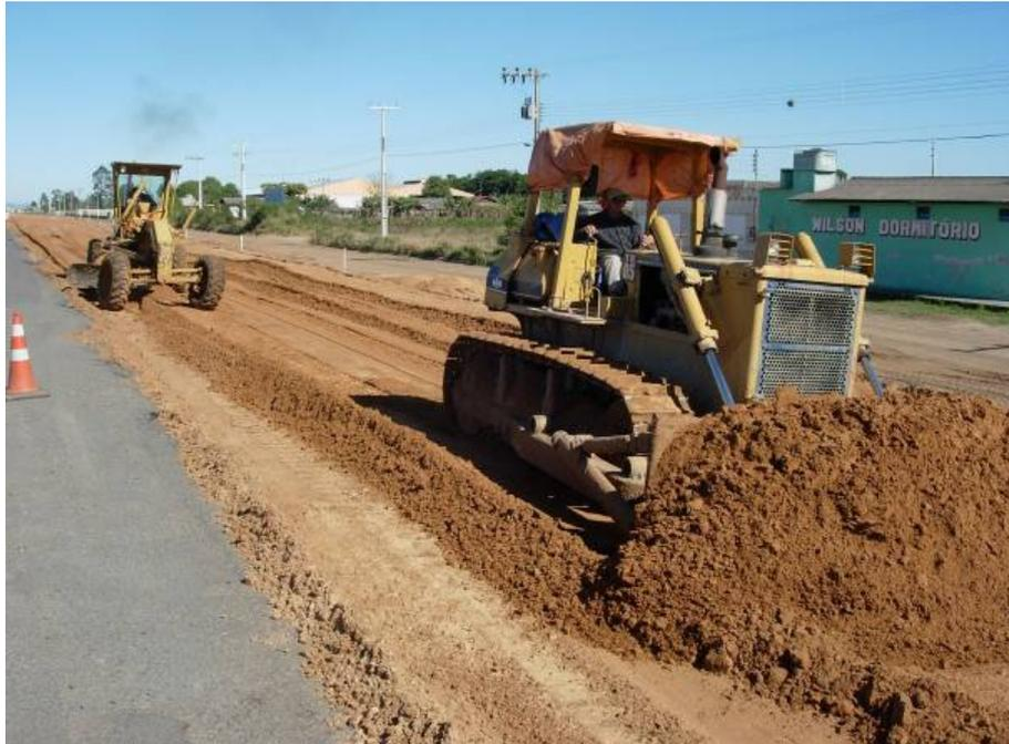
Figura 23 – Equipamentos para espalhamento de material.
