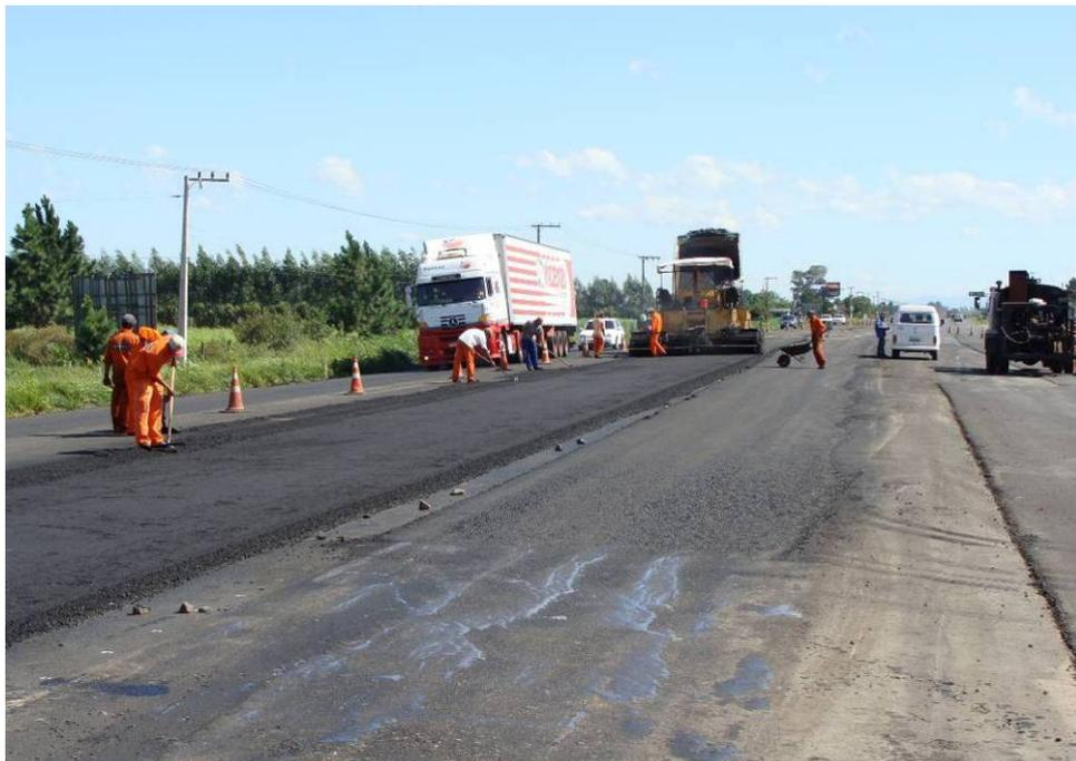
Figura 239 – Execução da camada de rolamento com massa asfáltica.
