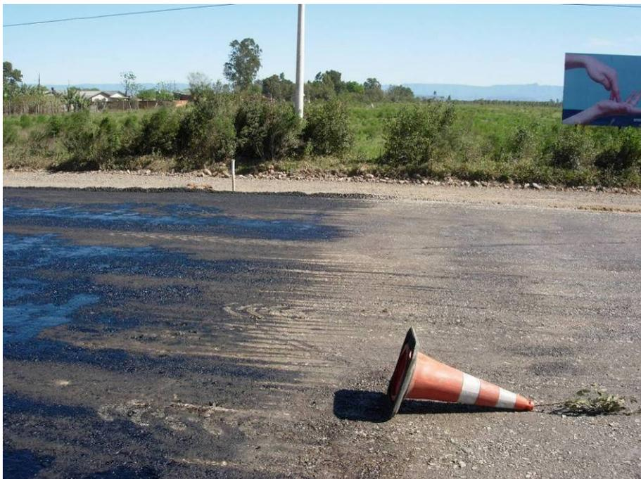
Figura 113 – Início do trecho com imprimação executada (5+740).
