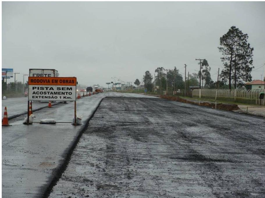
Figura 129 – BR-101 existente, 1ª camada de CBUQ e imprimação
