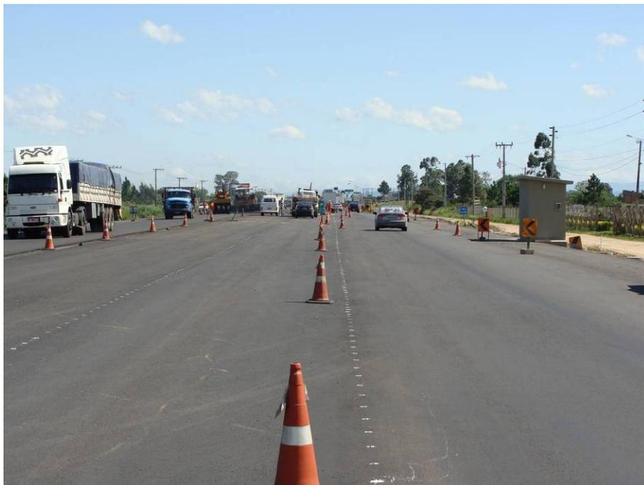
Figura 236 – Marcação para a aplicação de pintura da sinalização.
