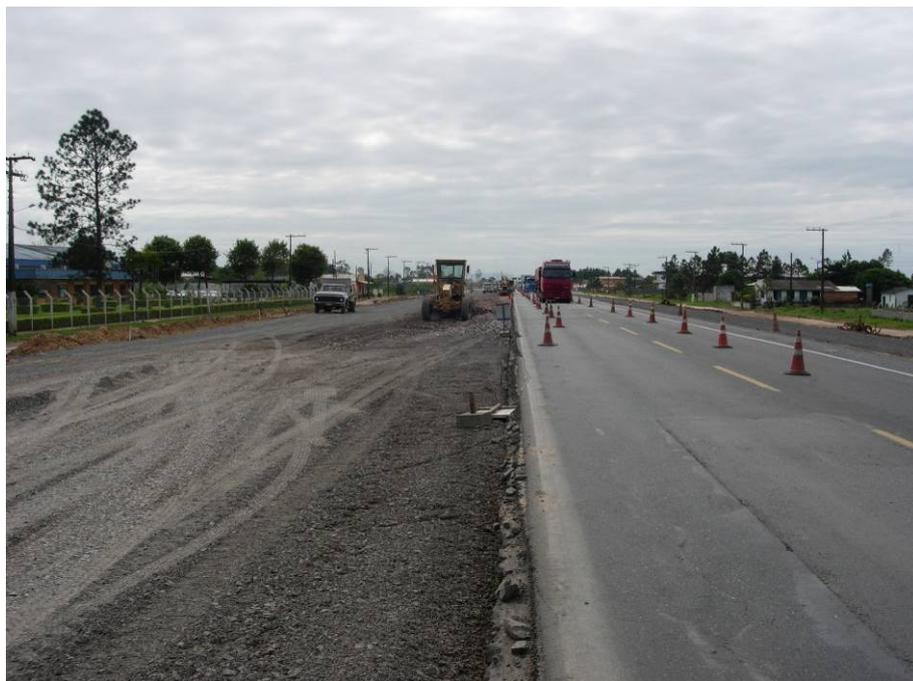
Figura 98 – Espalhamento da primeira camada com material de enchimento e travamento.
