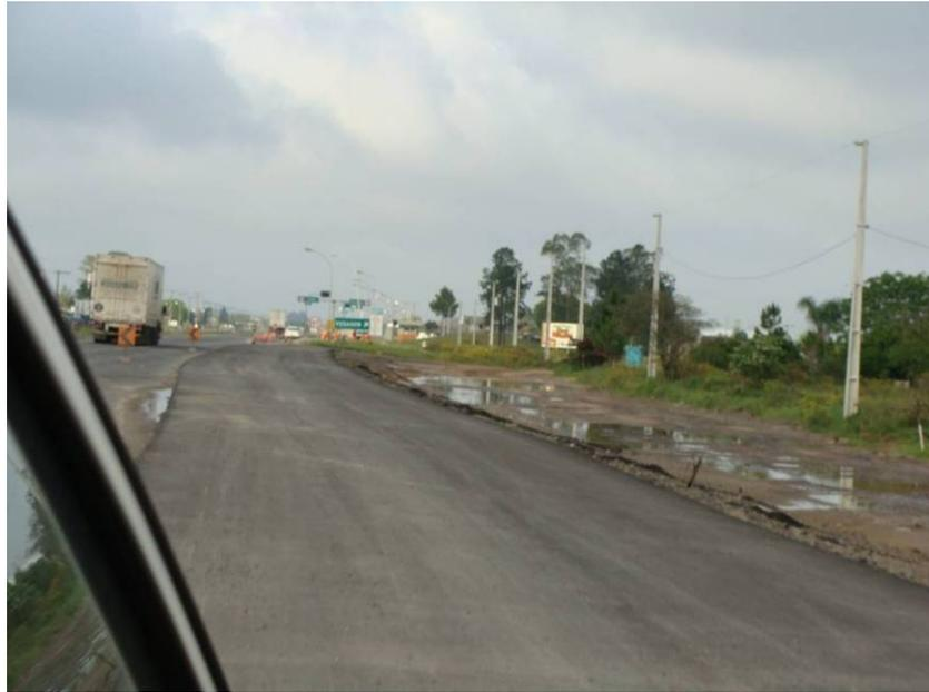
Figura 164 – Segmento final da pista com última camada executada.
