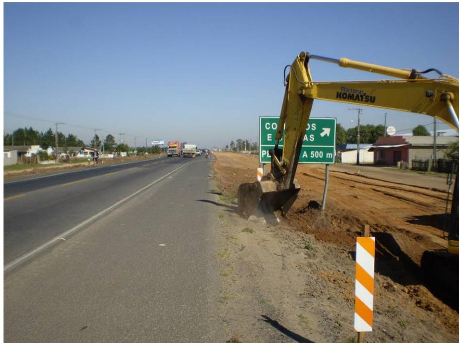
Figura 9– Remoção de material por retro escavadeira
