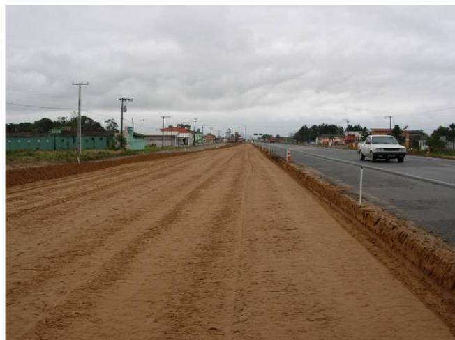
Figura 42 – Compactação da camada final de terraplenagem.
