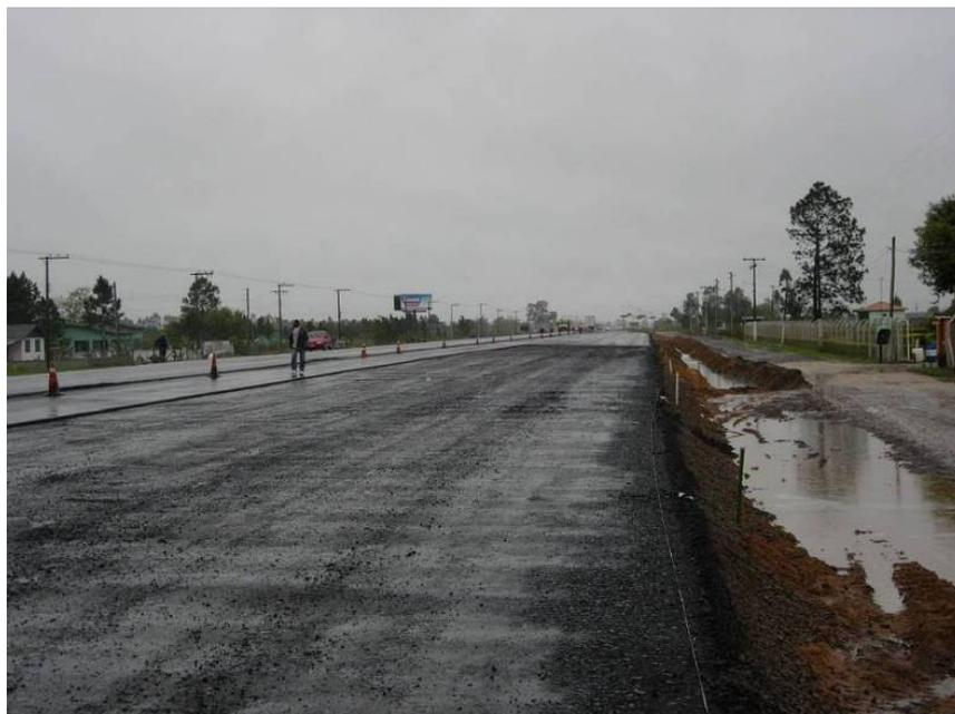
Figura 128 – Segmento à espera da execução da compactação da massa asfáltica.
