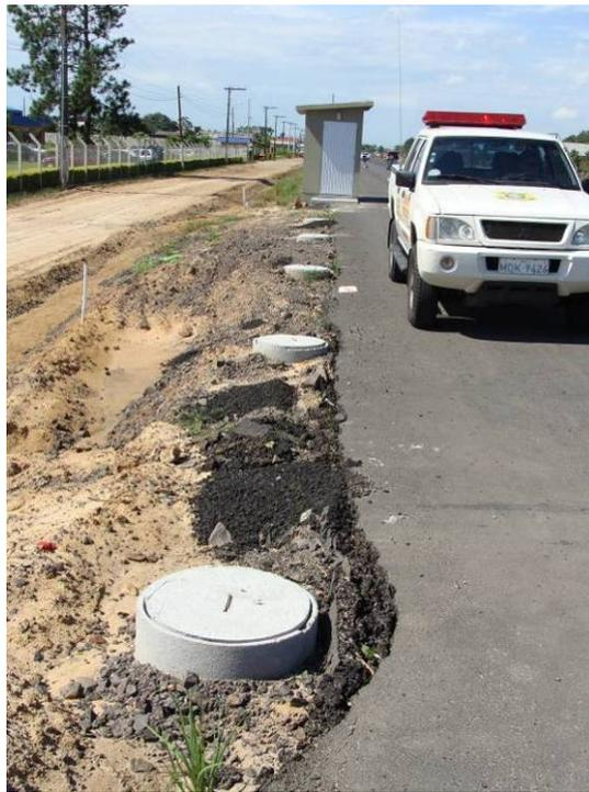
Figura 243 – Caixas externas de passagem para a fiação dos sensores parte sul.
