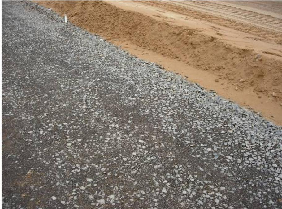
Figura 47 – Detalhes da camada de bloqueio.
