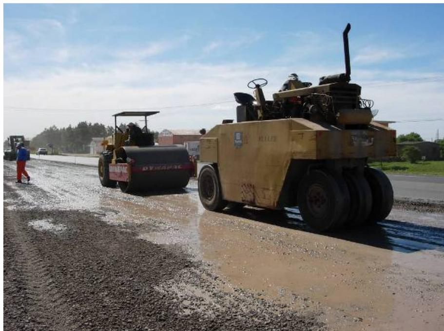
Figura 111 – Rolo compactador pneumático e rolo compactador vibratório.
