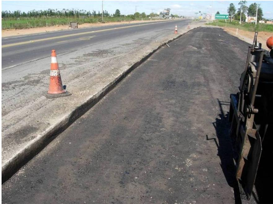
Figura 120 – Limites entre pista experimental e pavimento rígido (6+300).
