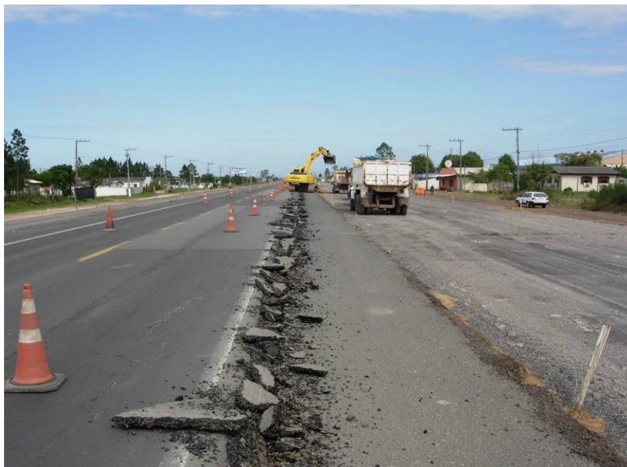
Figura 94 – Remoção do material do acostamento.
