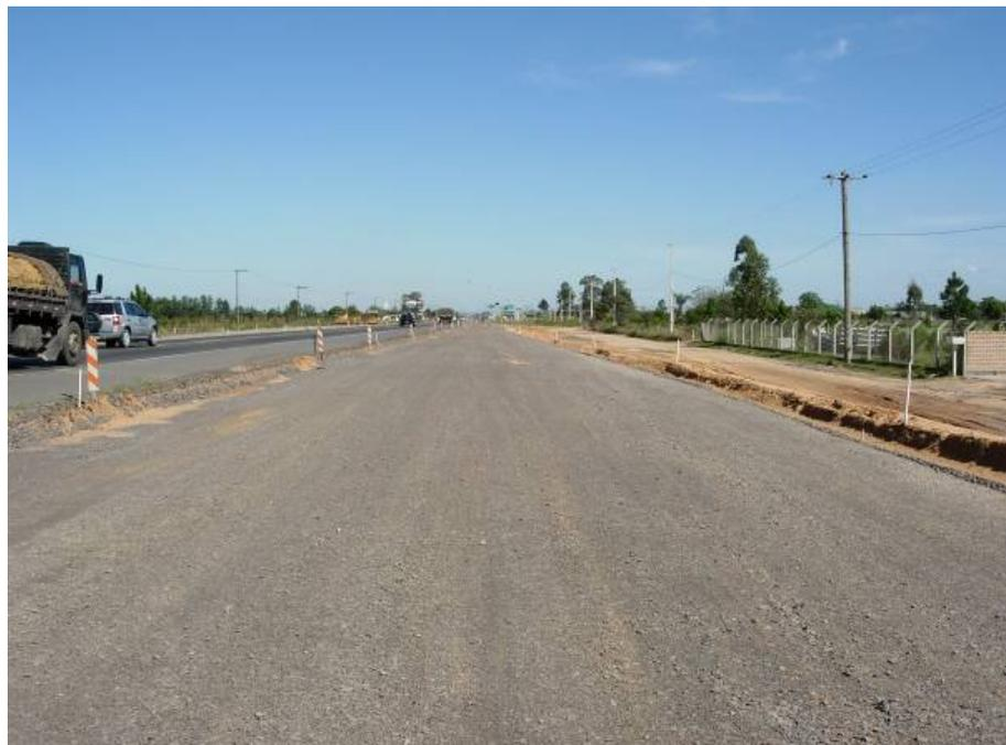
Figura 71 – Superfície da camada de bloqueio finalizada.
