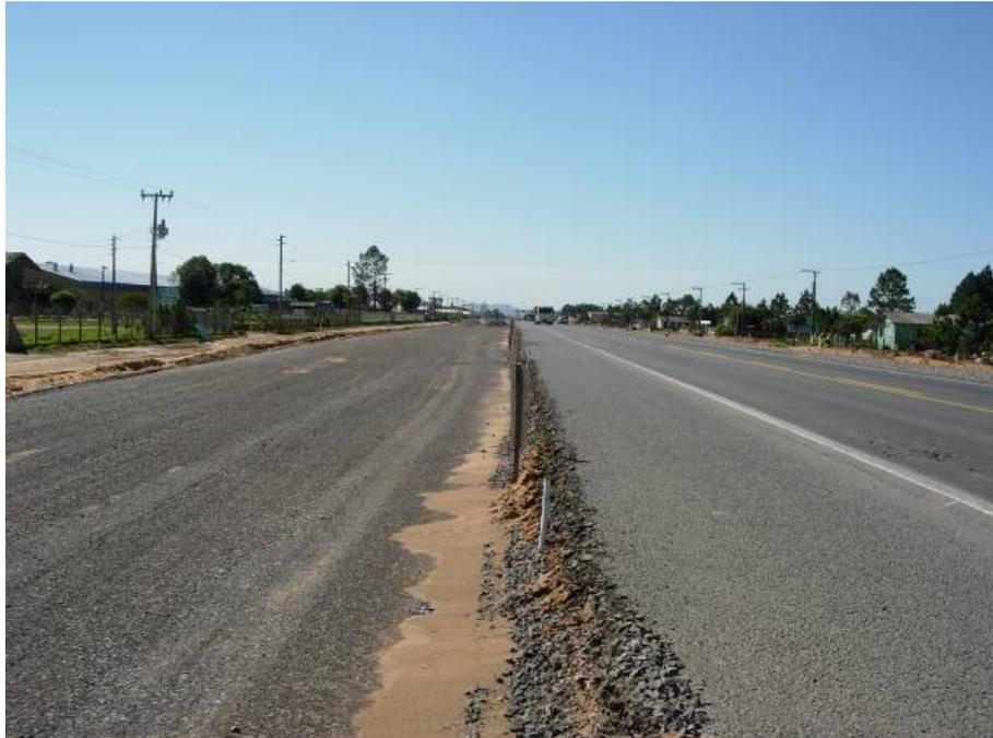
Figura 72 – Camada de bloqueio finalizada próximo ao acostamento.
