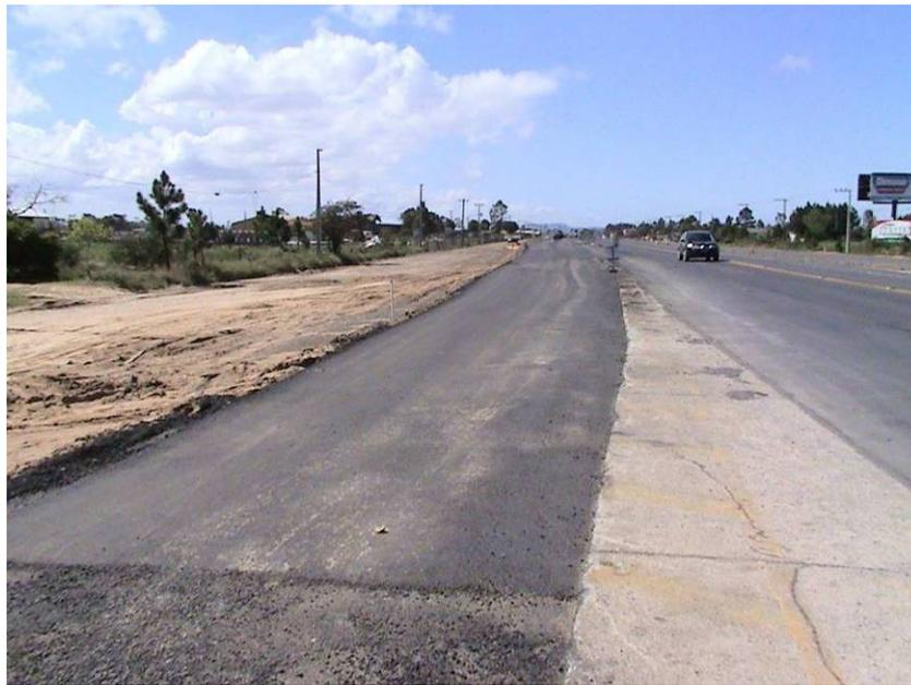
Figura 139 – Limites entre o pavimento rígido e pavimentação da pista.
