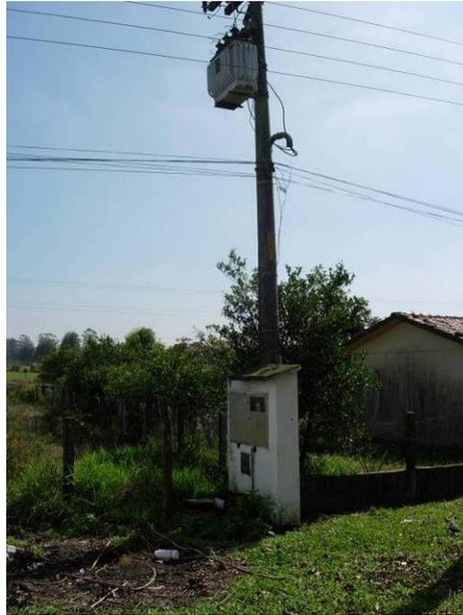
Figura 92 – Transformador e caixa de entrada de energia elétrica do posto de pesagem.
