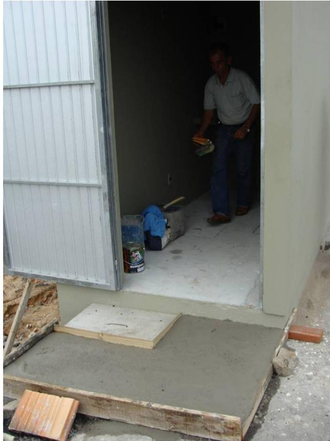
Figura 229 – Regularização do piso externo.
