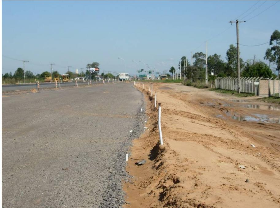
Figura 70 – Off-set correspondente ao deslocamento do eixo da BR101
