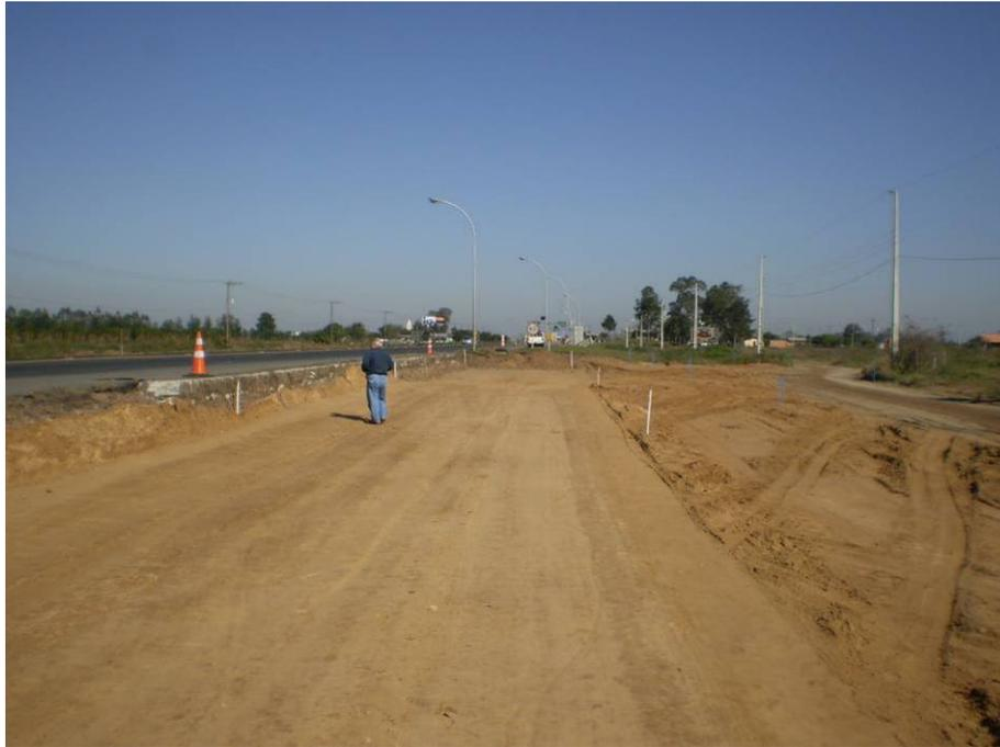
Figura 13 - Primeira camada do corpo do subleito compactada (próxima ao posto)
