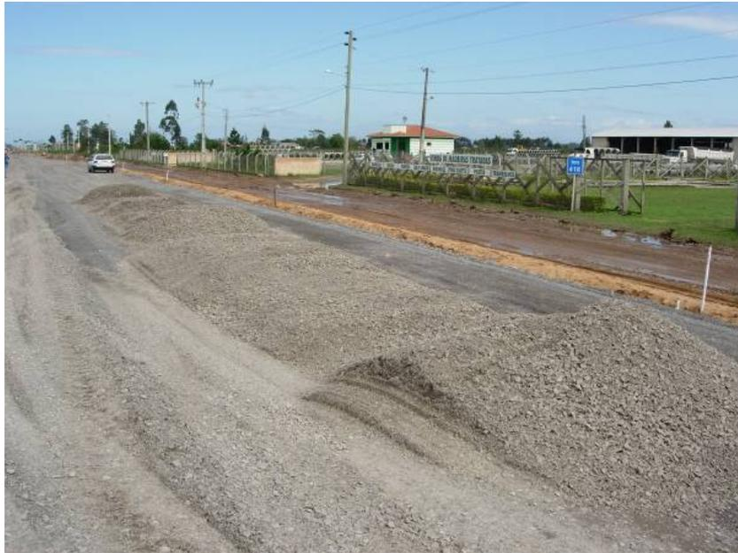
Figura 99 – Amontoados de material sobre a pista em construção.
