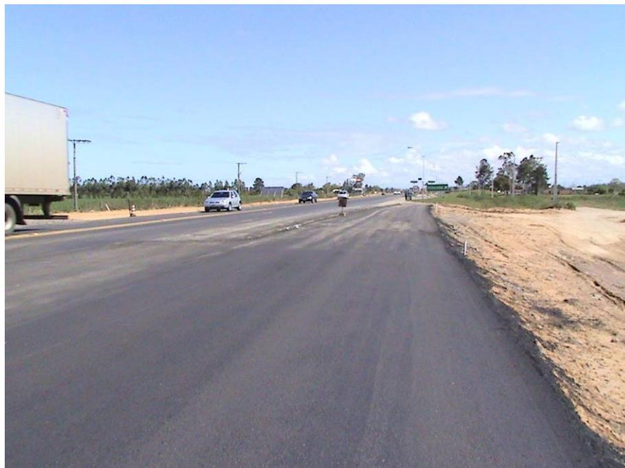
Figura 140 – Superfície da penúltima camada de asfalto.
