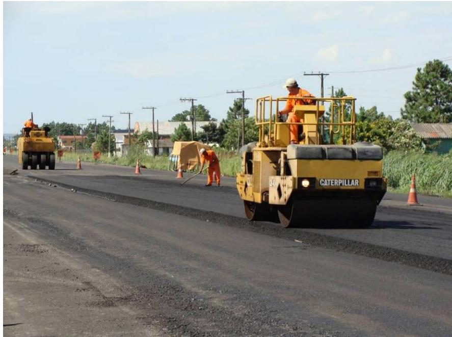
Figura 240 – Rolo compressor e rolo pneumático.
