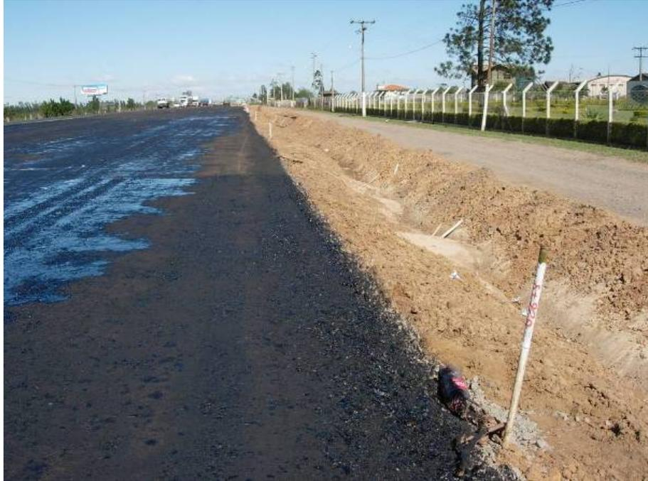
Figura 116 – Detalhe da borda direita externa com valeta de drenagem.
