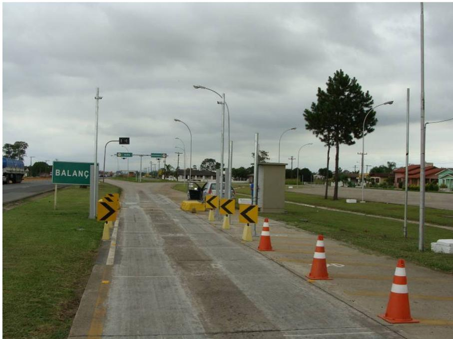
Figura 169 – Novos sensores para a balança de trânsito lento.
