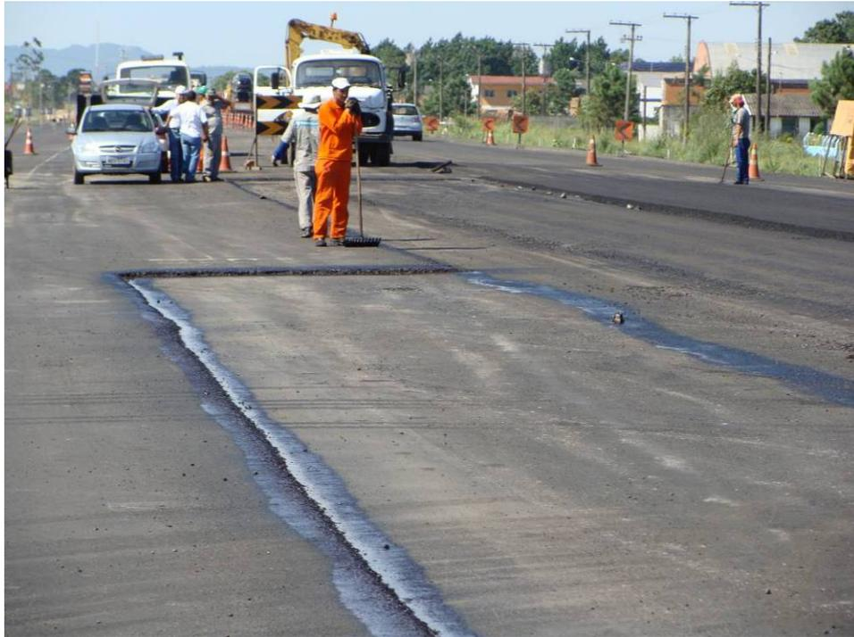
Figura 238 – Área com preparação para receber camada de massa asfáltica.
