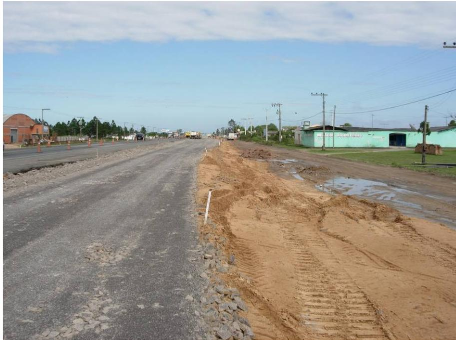
Figura 93 – Trecho inicial da pista com o material do subleito e sub-base.
