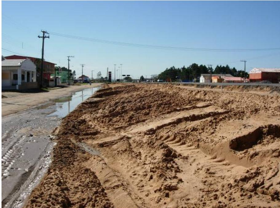
Figura 64 – Taludes de aterro na linha de off-set.
