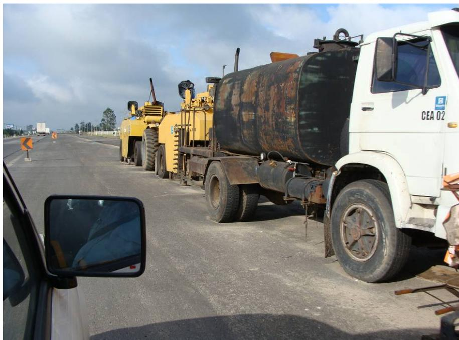
Figura 161 – Equipamentos em espera das massa asfáltica para execução.
