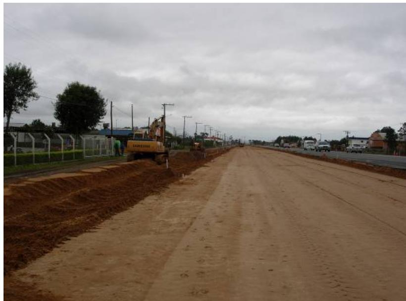
Figura 44 – Trecho com compactação concluída, vista “ré”.
