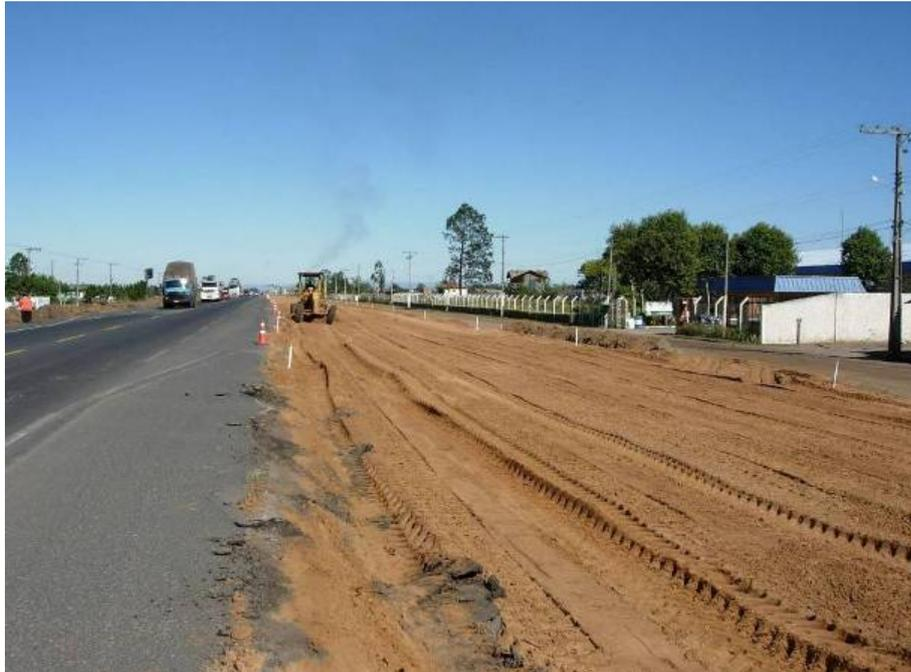
Figura 25 – Maquinários ao fundo para espalhamento da segunda camada do subleito.
