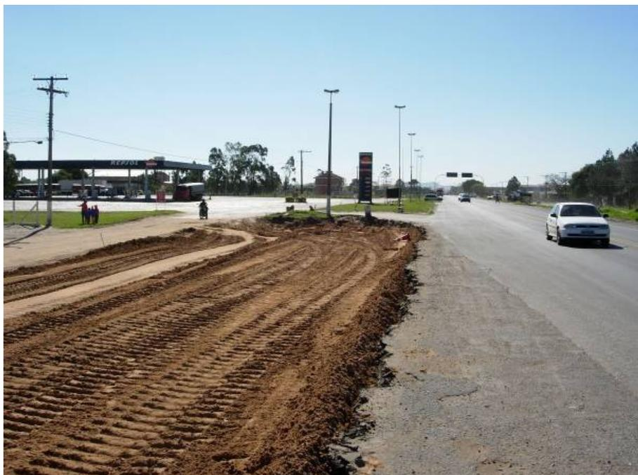
Figura 20 – Estaca inicial da obra, espalhamento do material do subleito.
