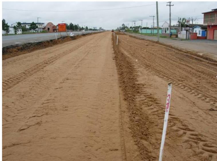
Figura 39 – Alinhamento da borda externa da pista estaca 5+480.
