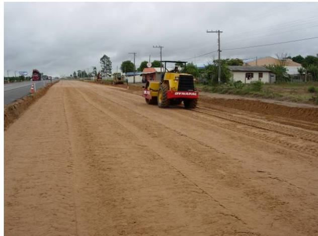
Figura 41 – Equipamento de compactação rolo vibratório.
