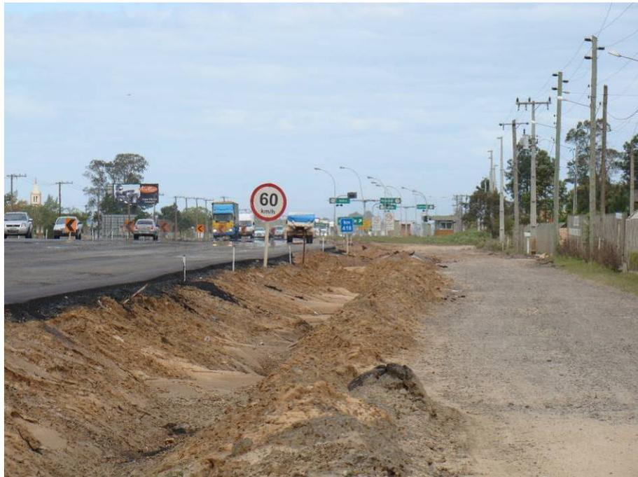
Figura 153 – Execução de rasgos para drenagem
