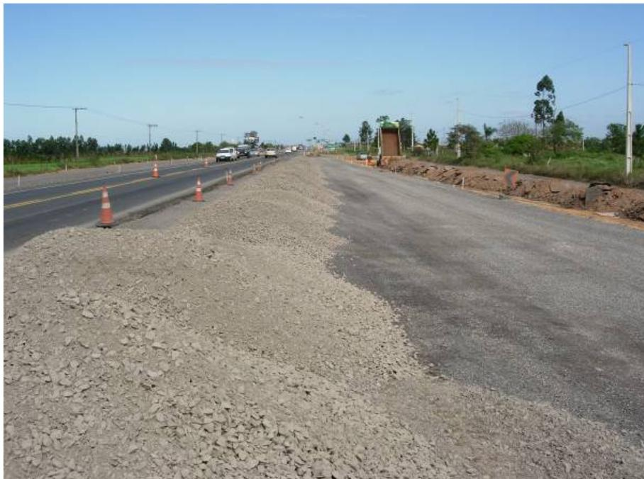
Figura 100 – Material para segunda camada de enchimento e travamento.
