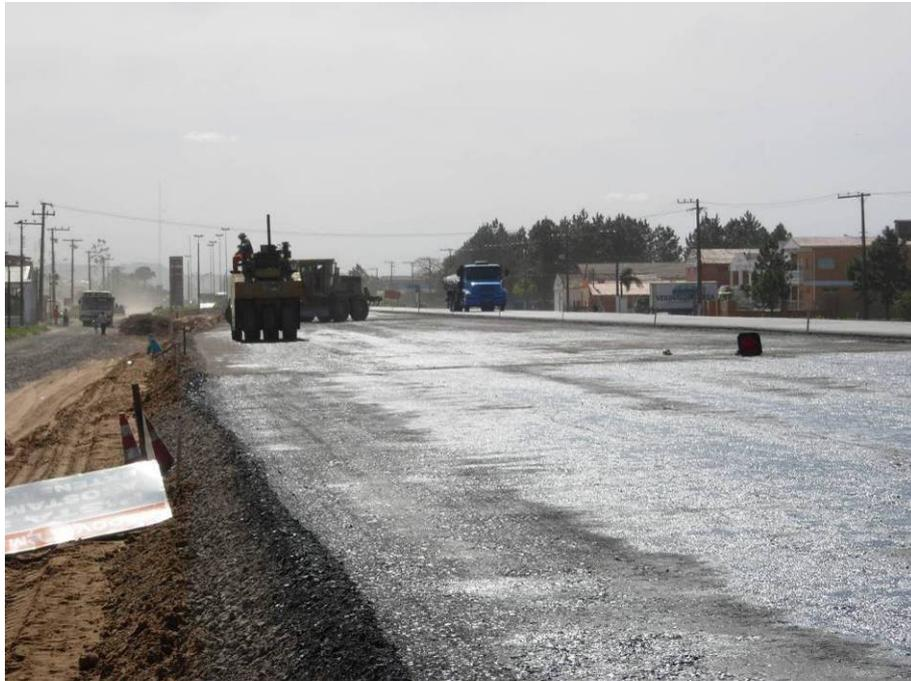
Figura 114 – Limite entre trechos com e sem imprimação (5+780)
