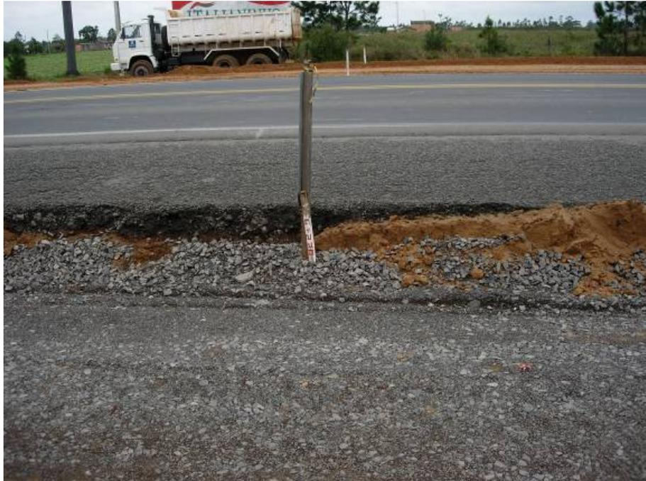
Figura 49 – Detalhe da junção entre a superfície do acostamento e camada de bloqueio.
