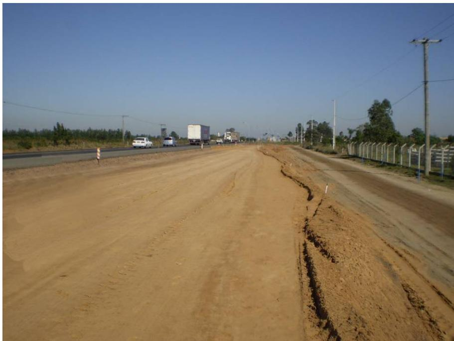
Figura 12 - Primeira camada do corpo do subleito compactada (vista final)
