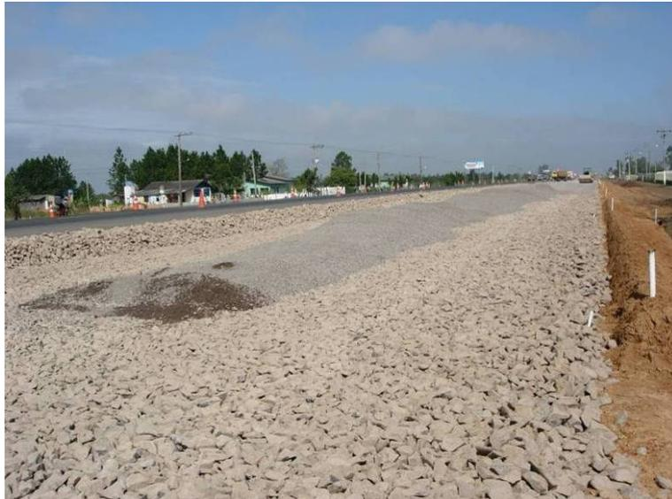
Figura 79 – Material componente da 1ª camada de enchimento (5+860).
