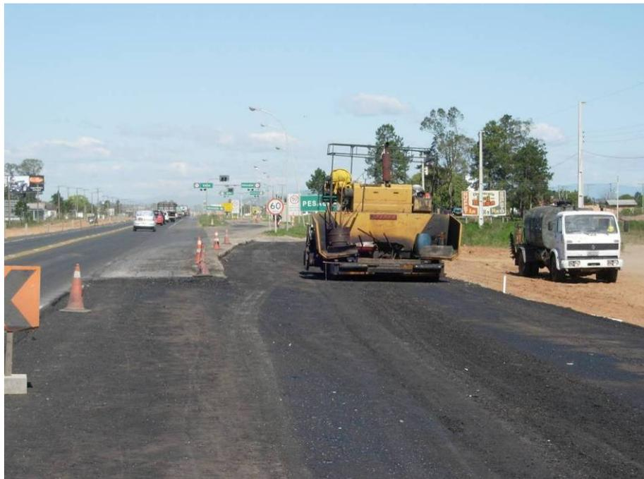
Figura 119 – Equipamento vibro acabadora niveladora de asfalto (6+200).
