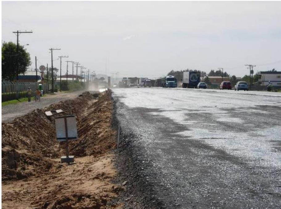
Figura 117 – Cortes para drenagem (5+920 e 6+000).
