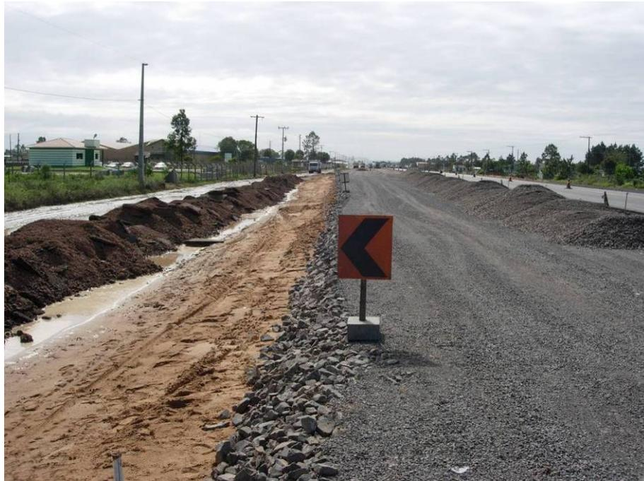
Figura 103 – Material do subleito da BR e material da sub-base.
