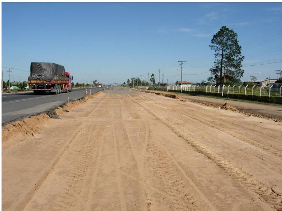
Figura 67 – Início da camada de bloqueio
