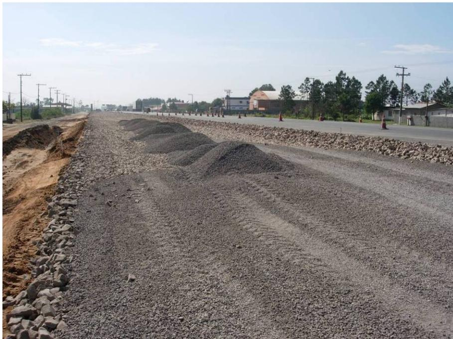
Figura 80 – Limite entre as duas camadas executadas.
