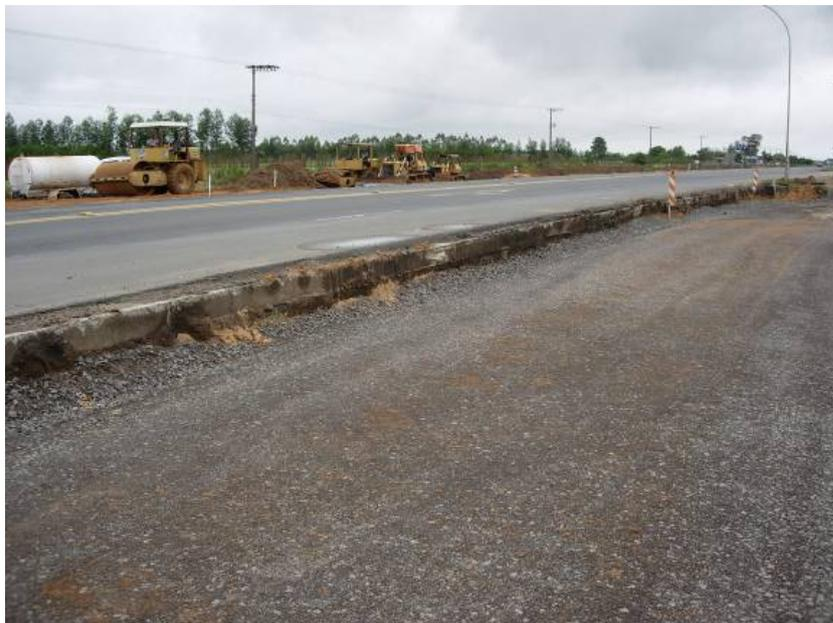
Figura 50 – Superfície dos materiais constituintes do bloqueio e camada de pavimento rígido.
