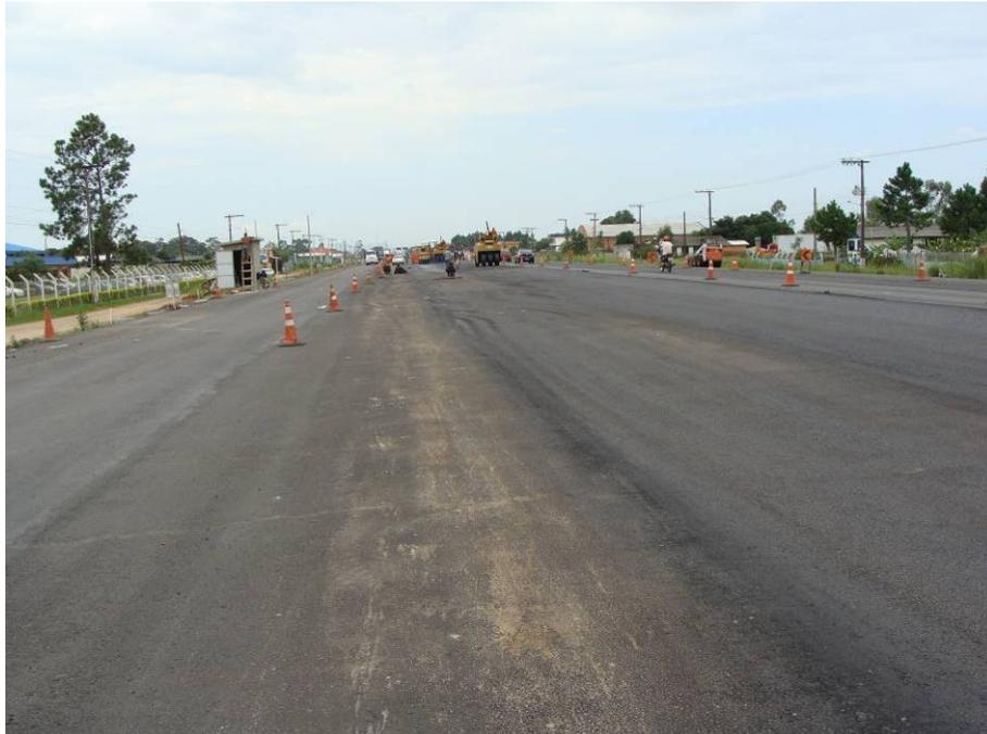
Figura 225 – Pavimentação do trecho onde se localiza 3ª faixa.
