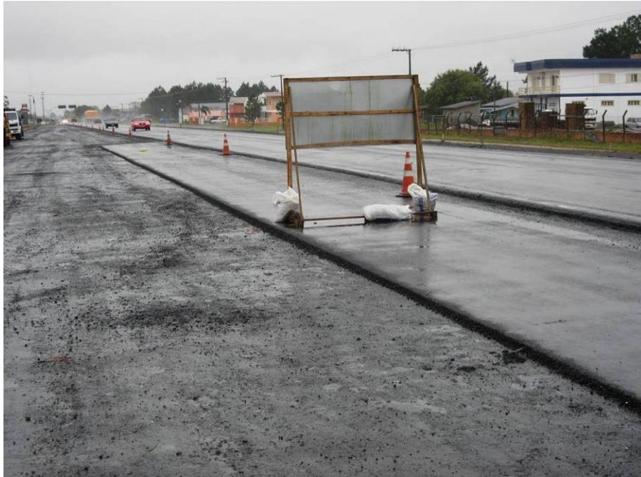
Figura 133 – Sinalização provisória de obras com cones e placas.
