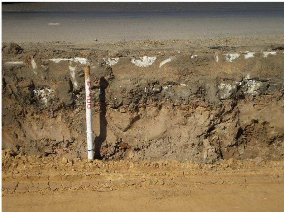
Figura 14 – Detalhe das camadas do pavimento rígido existente
