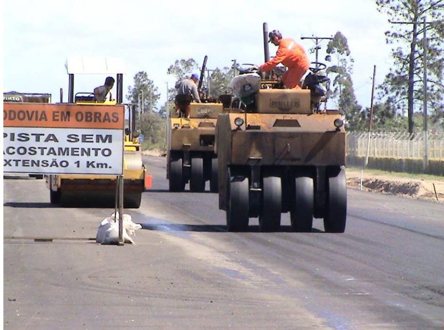
Figura 145 – Detalhes da execução da compactação pneumática e rolos.
