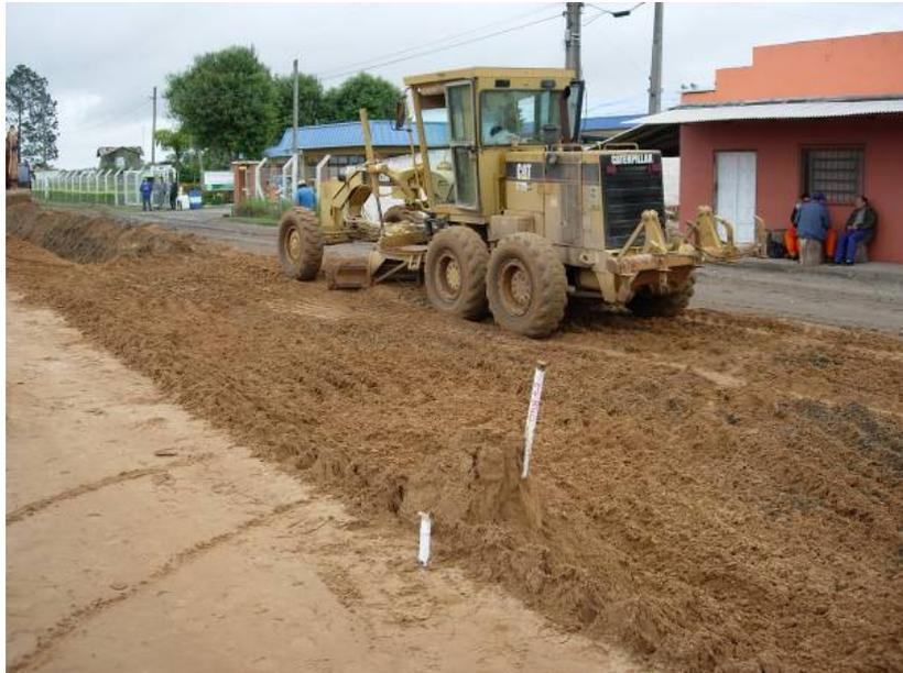
Figura 43 – Nivelamento do material componente das camadas
