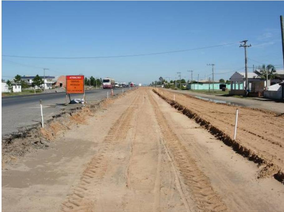
Figura 62 – Subleito da estrutura do pavimento
