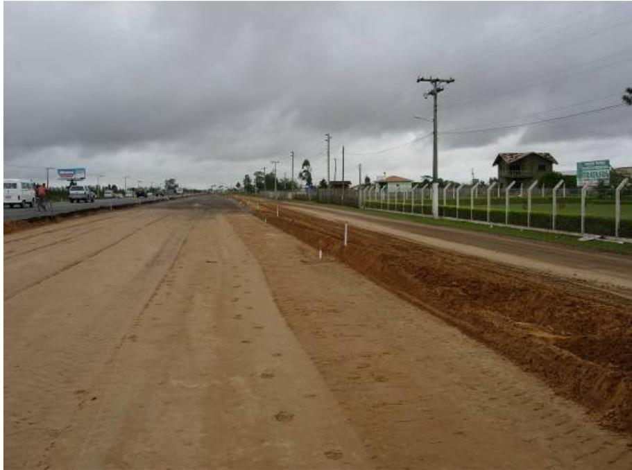
Figura 45 – Trecho com compactação concluída, vista avante.
