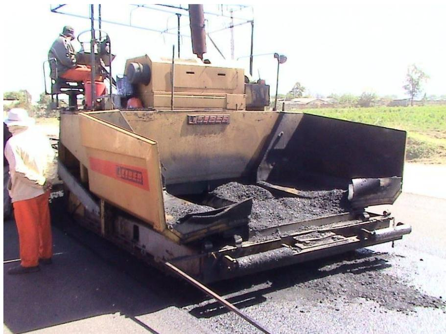
Figura 146 – Vibro-acabadora a espera de material da usina de asfalto.
