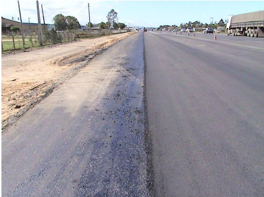
Figura 141 – Camadas executadas e em espera com imprimação.
