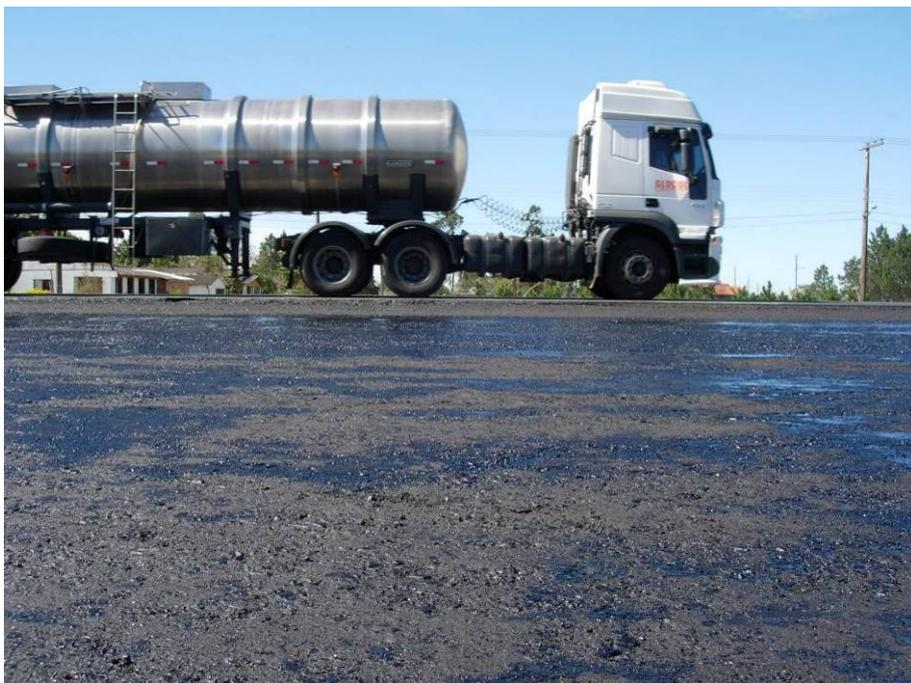
Figura 115 – Limite entre pavimento existente e imprimação (5+920).
