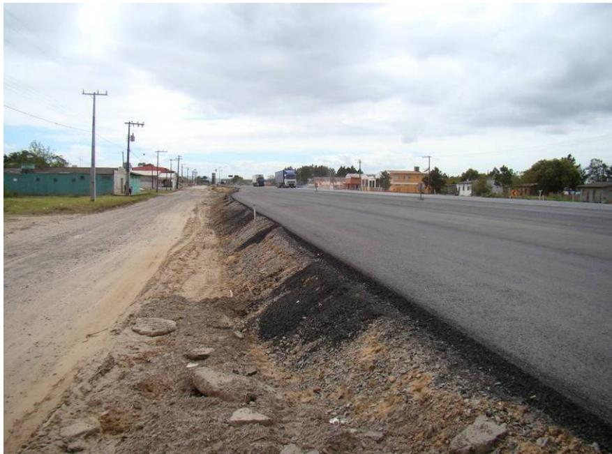
Figura 151 – Talude da plataforma da pista experimental.
