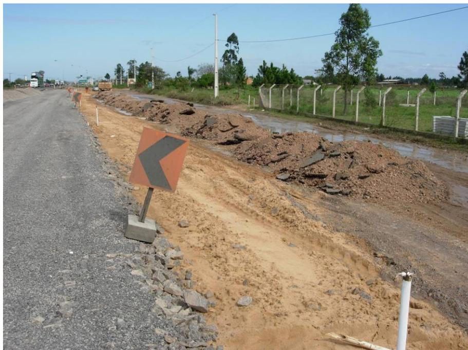
Figura 102 – Marginal direita com deposição do material de aterro.
