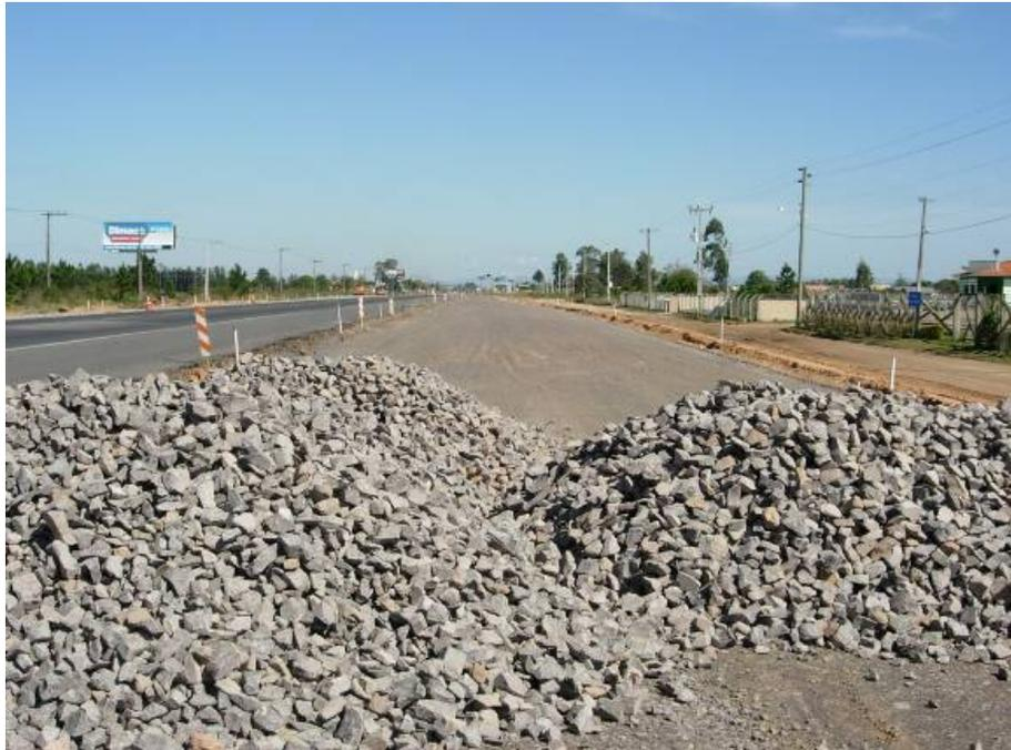
Figura 68 – Depósito de rachão sobre a pista.
