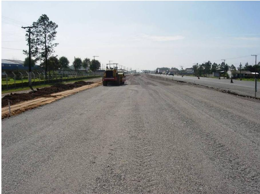
Figura 81 – Execução de compactação por rolo compactador vibratório.
