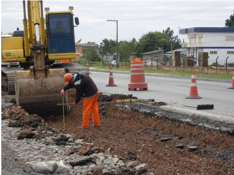
Figura 95 – Aferição da profundidade de projeto.
