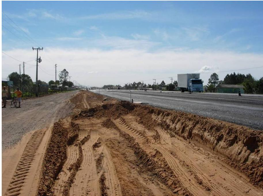
Figura 118 – Nivelamento da área pertencente a marginal direita (6+180).
