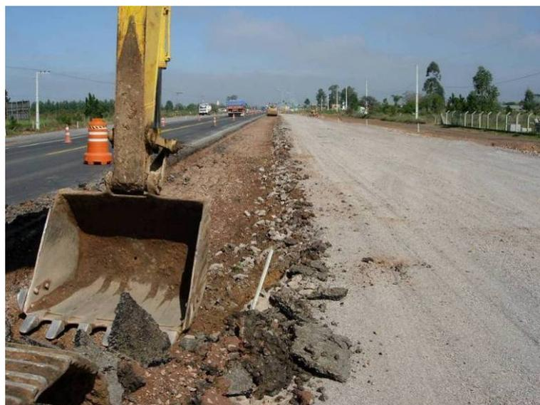
Figura 82 – Retro-escavadeira e remoção do material do acostamento.
