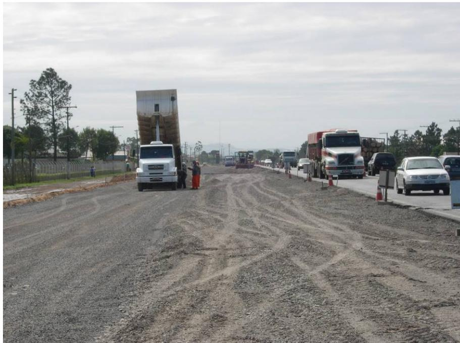
Figura 101 – Deposição do material componente da camada de enchimento e travamento.
