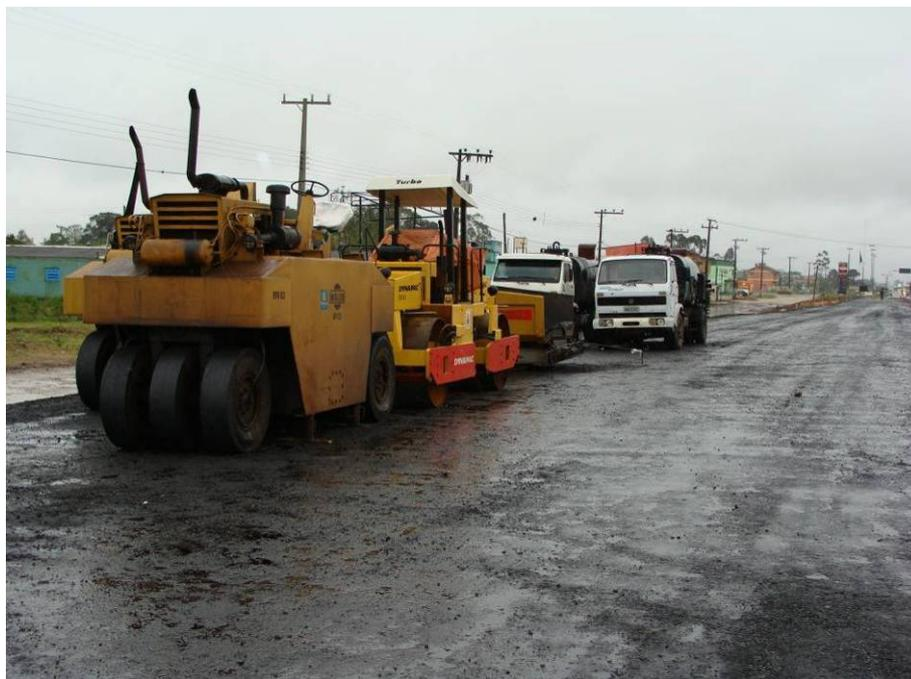
Figura 130 – Rolos, vibro-acabadora e caminhões pipa.
