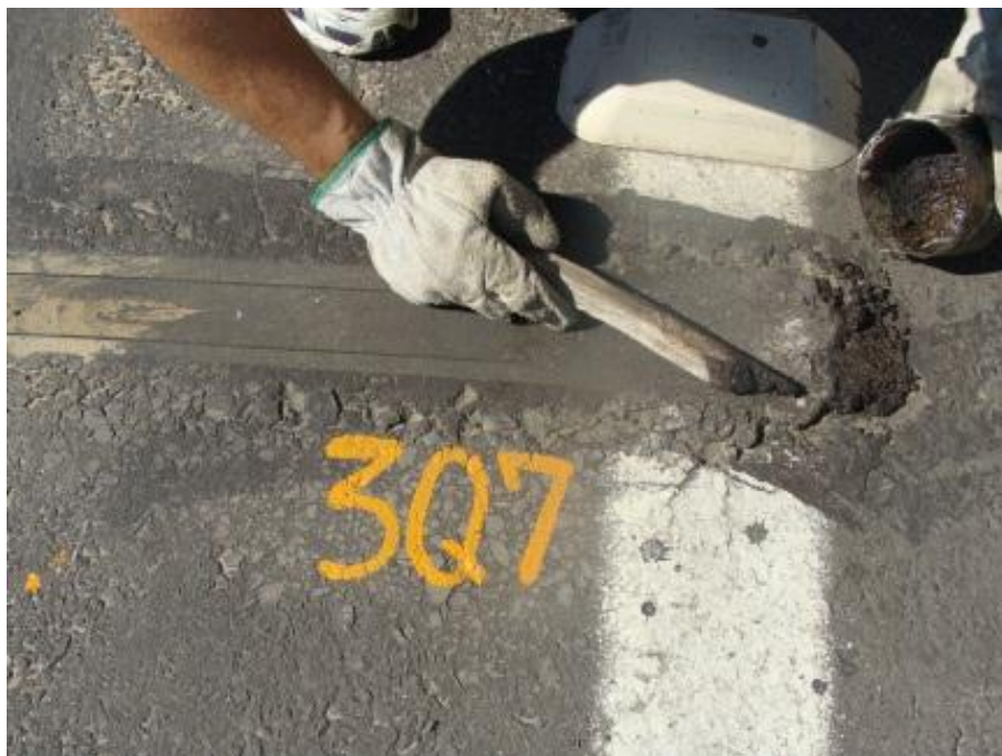
Figura 38 - Preenchimento com CM-30.
