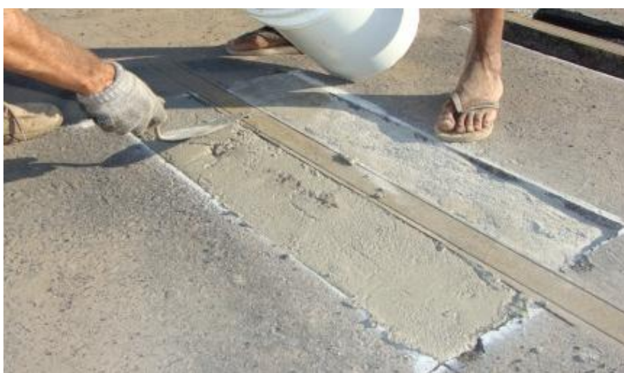
Figura 17 - Acabamento do GROUTTEK LFR 1 BRANCO.
