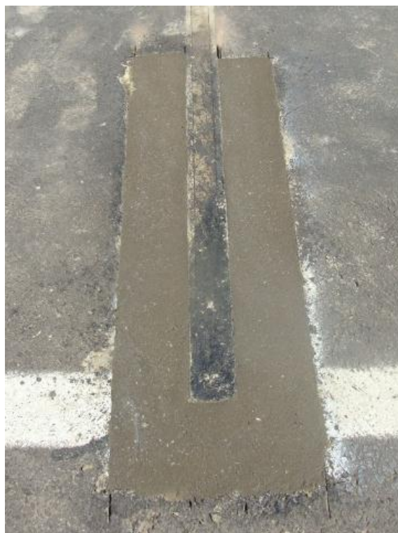
Figura 33 - Restauração com GROUTEK AN.
