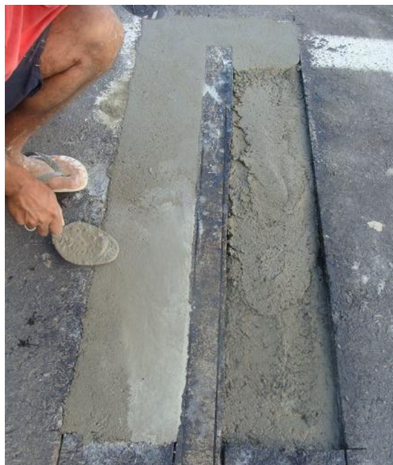
Figura 31 - Aplicação do GROUTER AN na restauração do pavimento.
