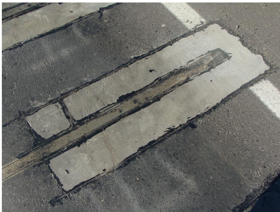
Figura 55 - Aspecto final da abertura 3Q27 após 30 dias de tráfego.
