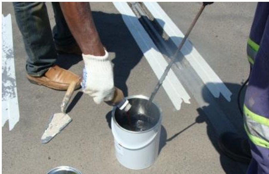
Figura 76 - Mistura do endurecedor com a resina.
