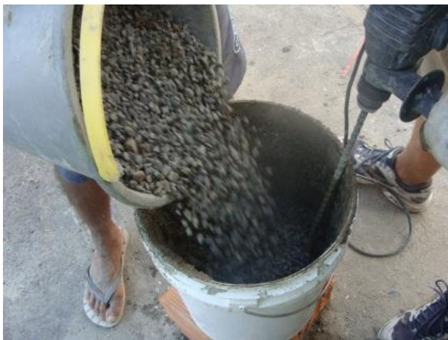
Figura 32 - Adição de 12,5 kg de pedrisco para 25 kg de GROUTER AN.
