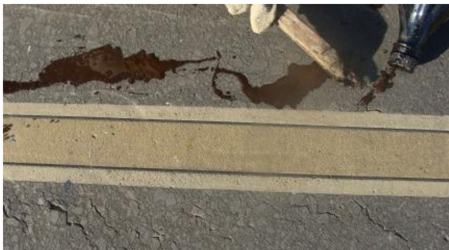
Figura 37 - Aplicação do CM-30 nas trincas e rachaduras.
