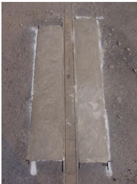
Figura 18 - Aspecto final da restauração com GROUTEK LFR 1 BRANCO.
