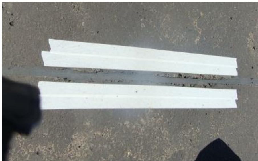
Figura 84 - Proteção com fita adesiva nos sensores óticos.
