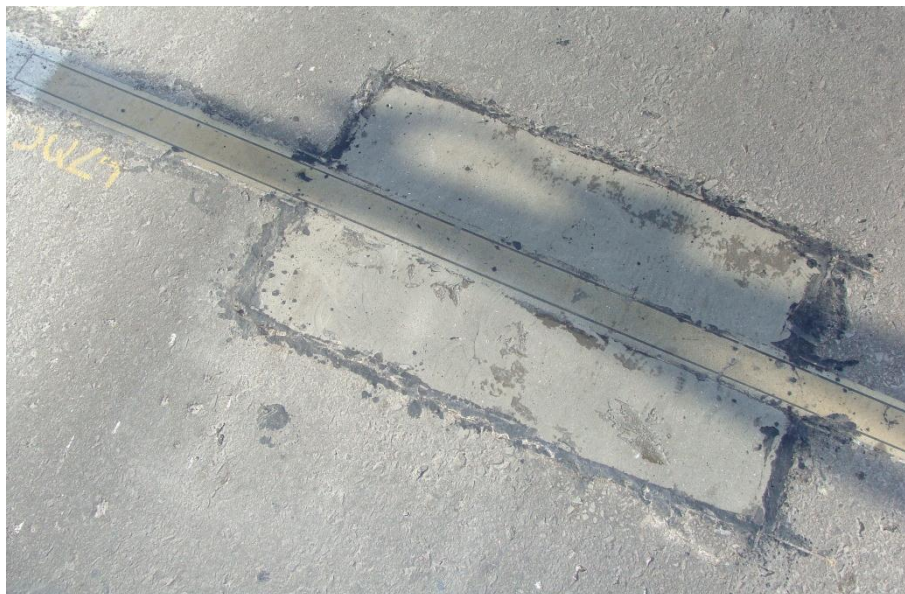
Figura 44 - Aspecto final da abertura 3Q24 após 30 dias de tráfego.
