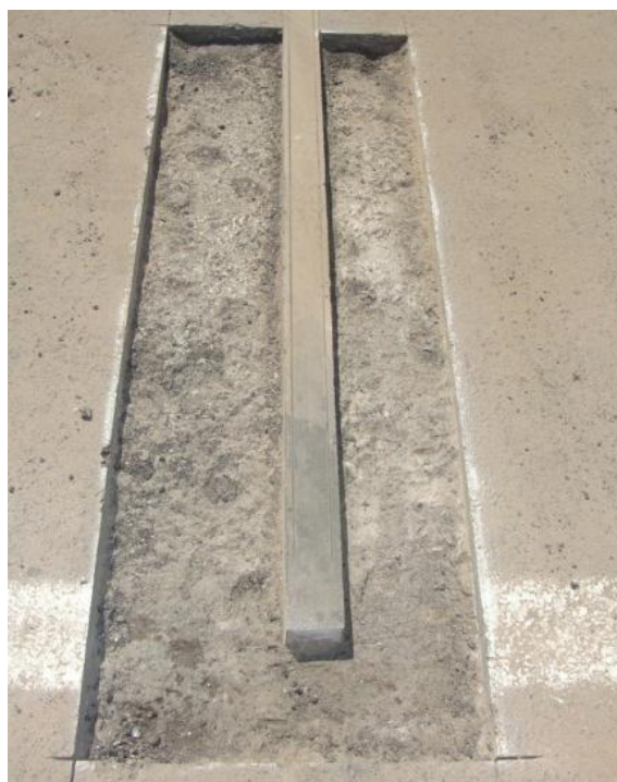
Figura 13 - Abertura para o preenchimento com graute.
