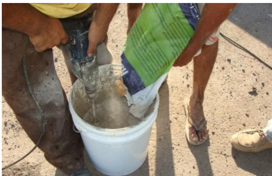
Figura 15 - Mistura dos componentes do LFR 1 BRANCO.
