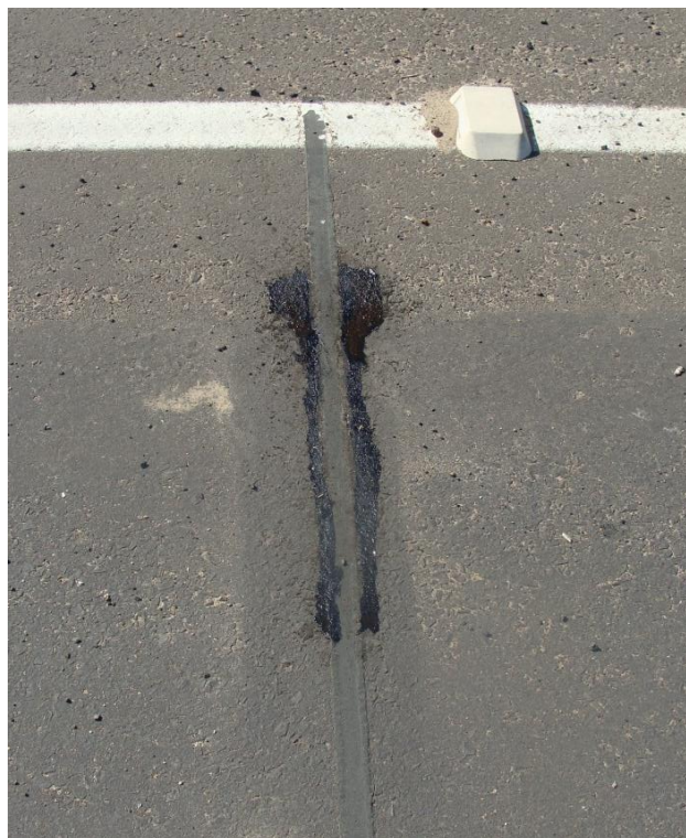
Figura 81 - Preenchimento com CM-30 ao redor dos sensores polímeros.
