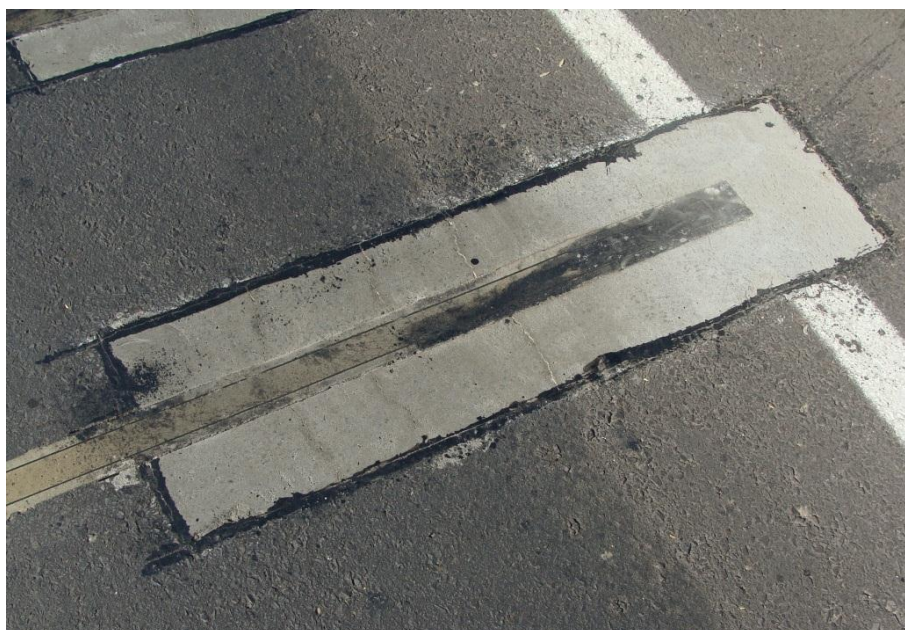
Figura 47 - Aspecto final da abertura 3Q05 após 30 dias de tráfego.
