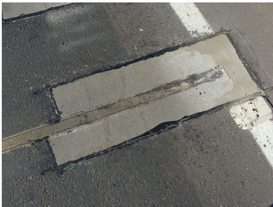
Figura 49 - Aspecto final da abertura 3Q15 após 30 dias de tráfego.
