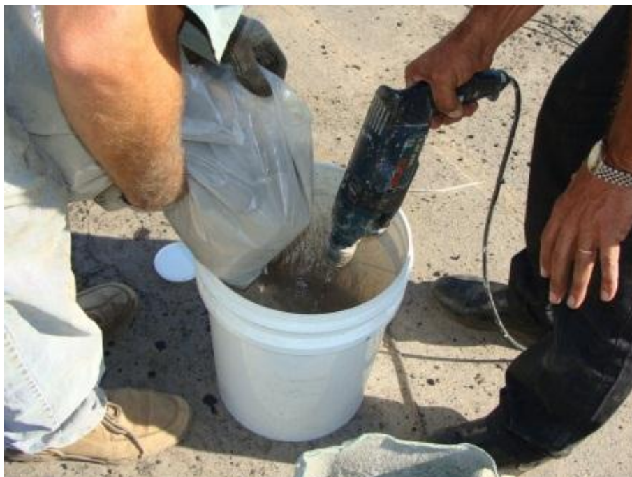
Figura 21 - Adição do componente C.
