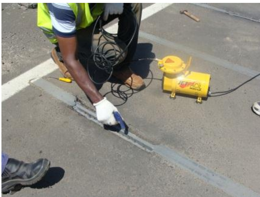
Figura 71 - Limpeza do local de reposição dos grautes.
