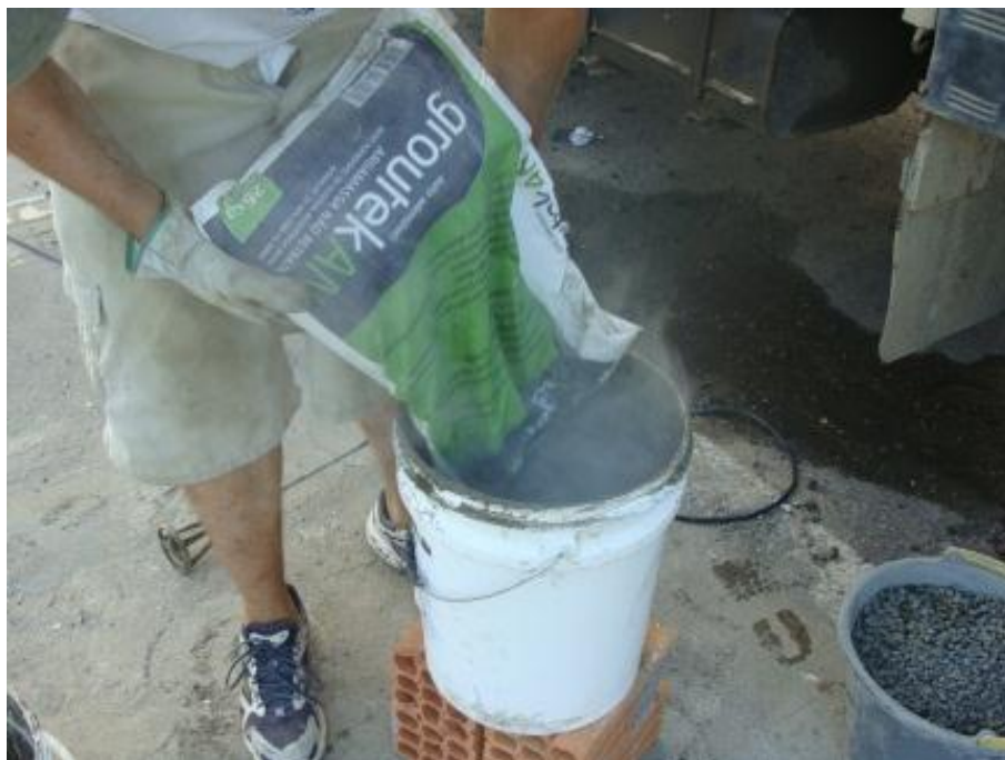
Figura 29 - Mistura do graute AN com água.
