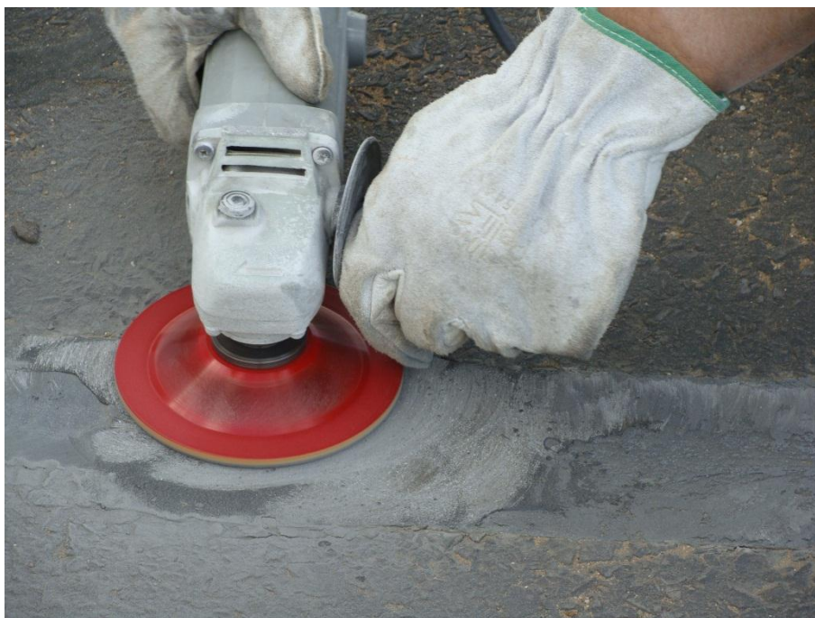
Figura 79 - Lixamento dos sensores cerâmicos.
