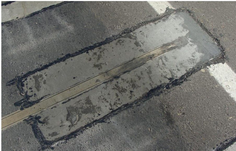
Figura 56 - Aspecto final da abertura 3Q29 após 30 dias de tráfego.
