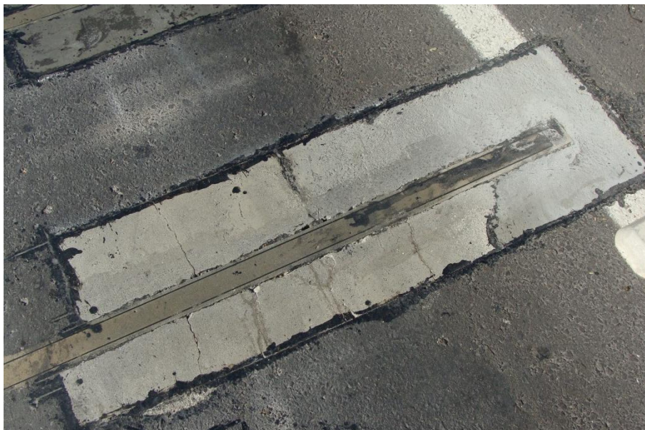
Figura 57 - Aspecto final da abertura 3Q31 após 30 dias de tráfego.
