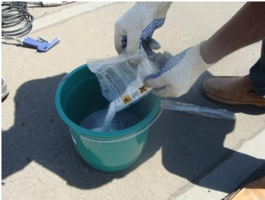
Figura 74 - Adição do catalisador PERKADOX CH-34RP.
