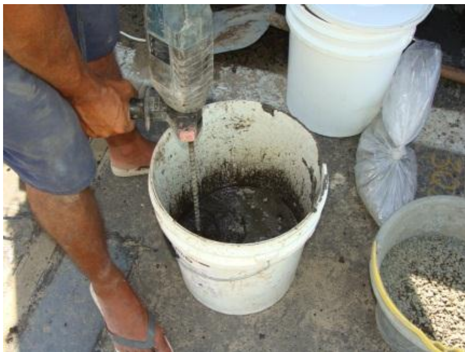
Figura 22 - Agitação do HAGENHARD GROUT por 6 minutos.
