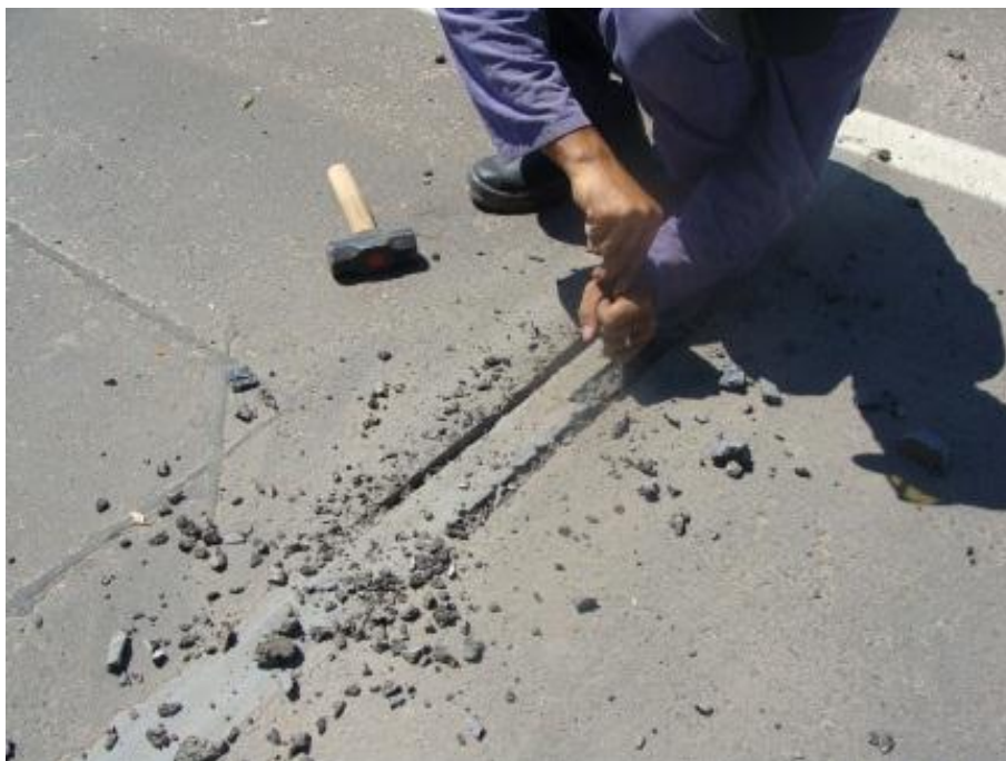
Figura 70 - Retirada dos grautes danificados.
