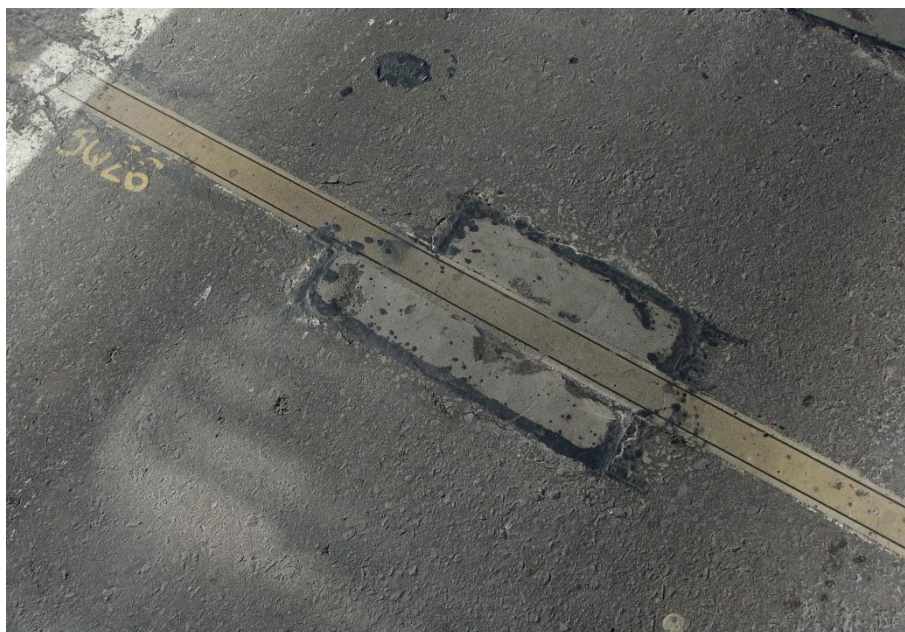
Figura 45 - Aspecto final da abertura 3Q26 após 30 dias de tráfego.
