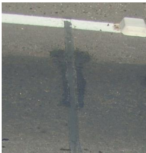
Figura 82 - Aspecto final da restauração do sensor polímero.
