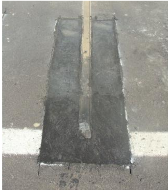
Figura 26 - Restauração com HAGENHARD GROUT.
