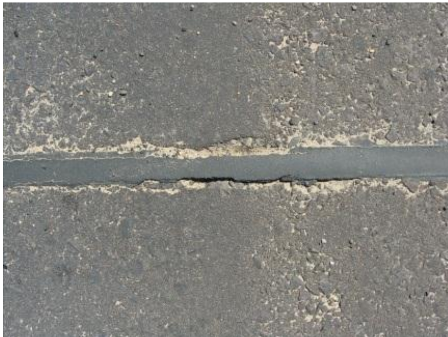
Figura 80 - Deterioração do redor dos sensores polímeros.
