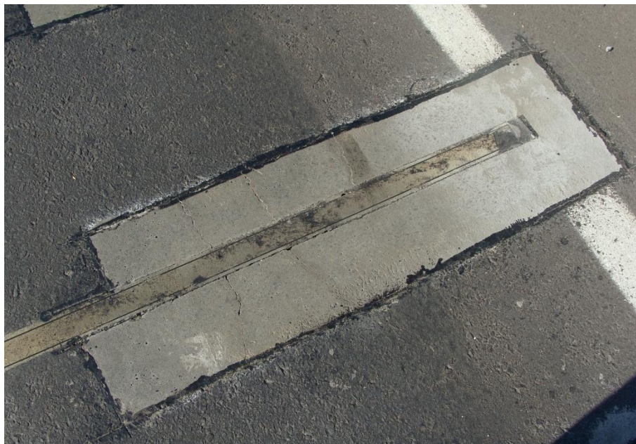
Figura 50 - Aspecto final da abertura 3Q17 após 30 dias de tráfego.
