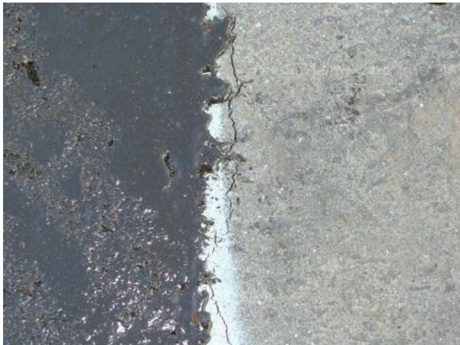
Figura 27 - Efeito da contração-retração do graute.
