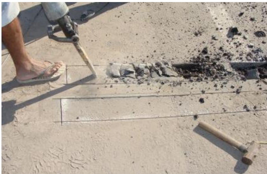
Figura 12 - Retirada do concreto asfáltico danificado.
