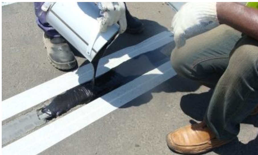
Figura 77 - Aplicação do graute nos sensores cerâmicos.
