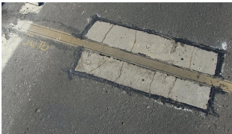
Figura 41 - Aspecto final da abertura 3Q18 após 30 dias de tráfego.
