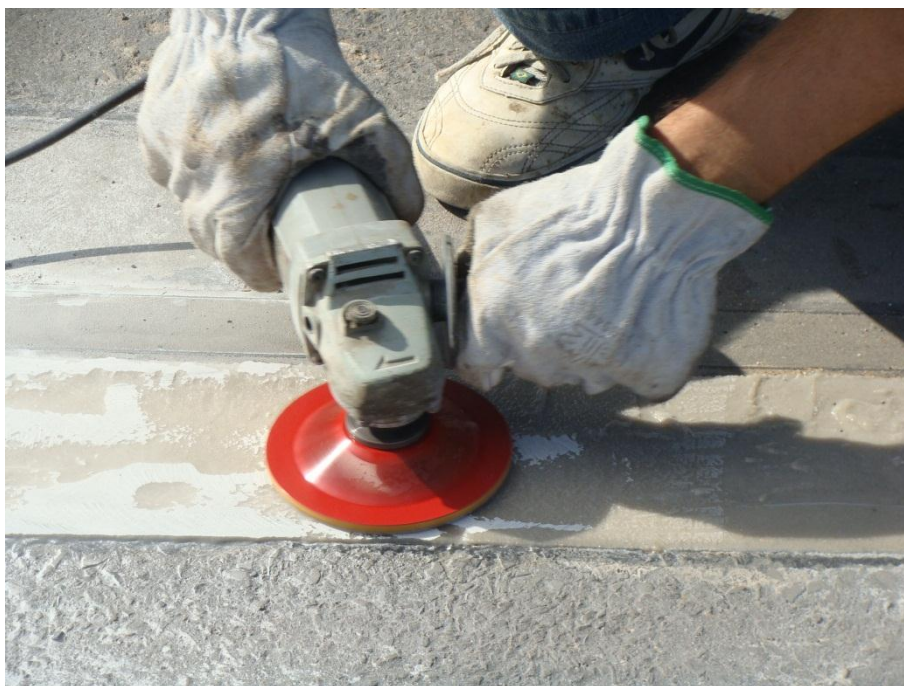
Figura 66 - Lixamento da restauração.
