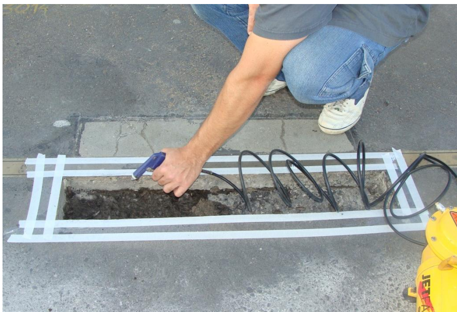
Figura 60 - Limpeza do local da restauração.
