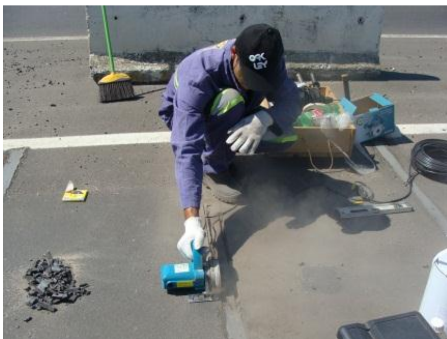
Figura 69 - Corte ao redor dos sensores cerâmicos.
