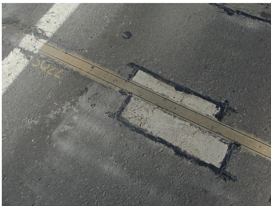
Figura 43 - Aspecto final da abertura 3Q22 após 30 dias de tráfego.
