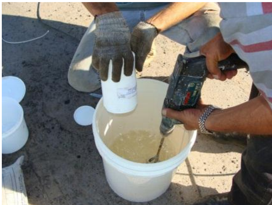
Figura 20 - Mistura dos componentes A + B.
