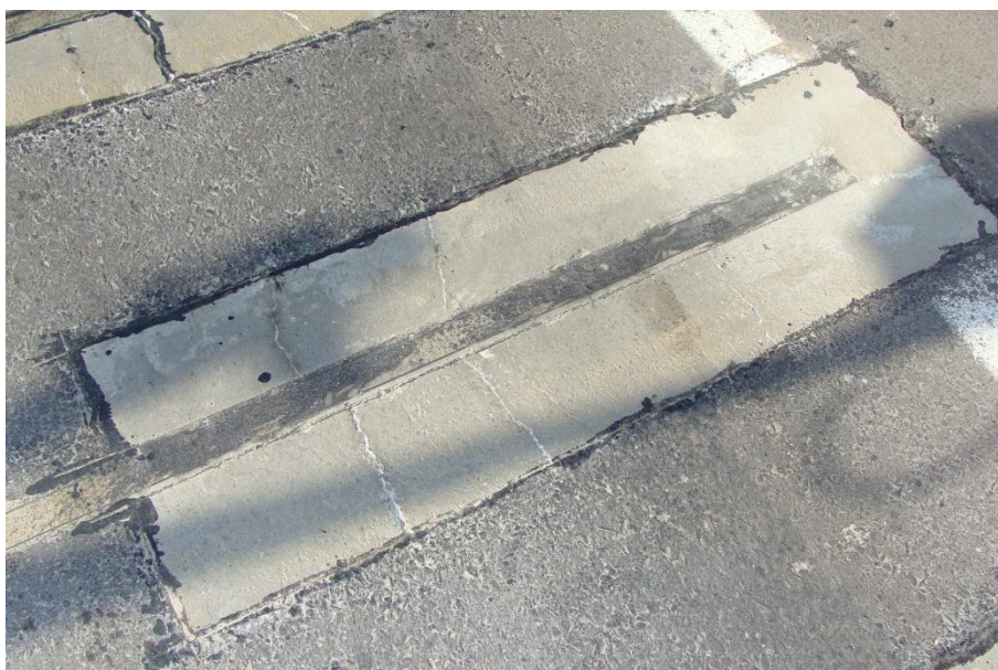
Figura 53 - Aspecto final da abertura 3Q23 após 30 dias de tráfego.
