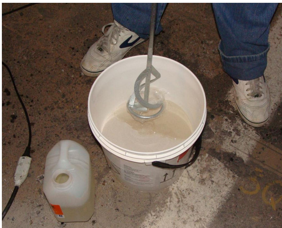
Figura 62 - Mistura da resina TYP1000A1 com finos.
