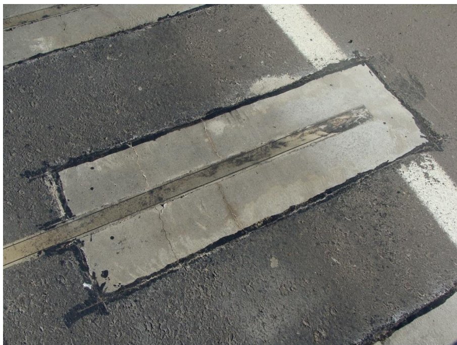
Figura 51 - Aspecto final da abertura 3Q19 após 30 dias de tráfego.
