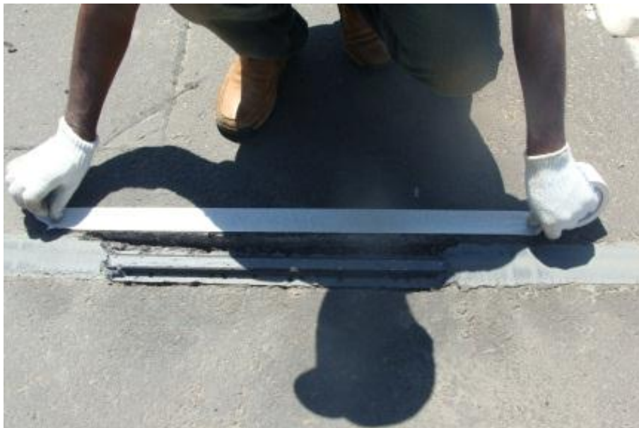
Figura 72 - Proteção contra vazamento.
