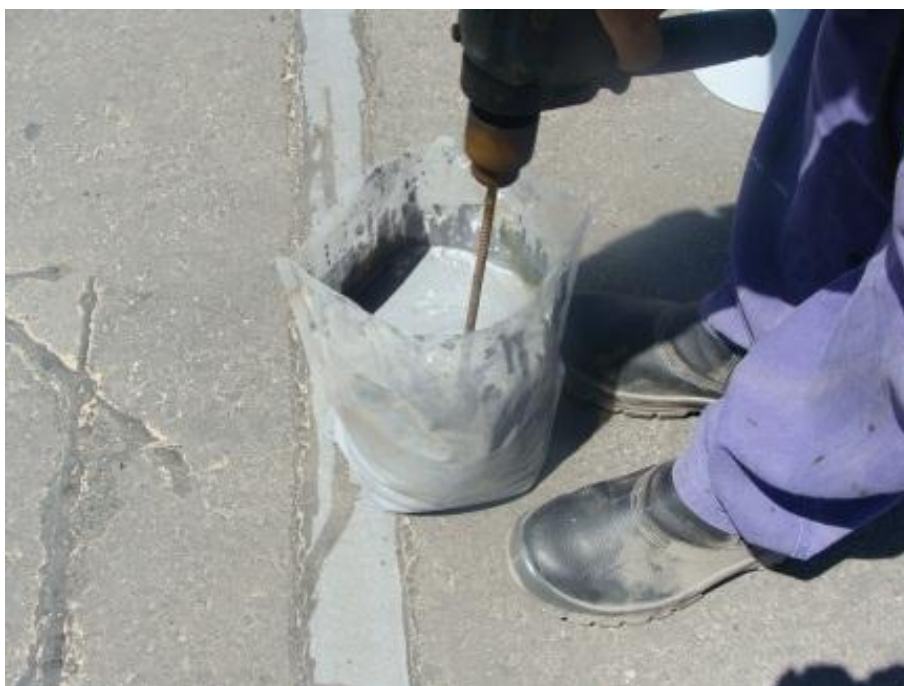
Figura 73 - Mistura do graute PLASTIROC.
