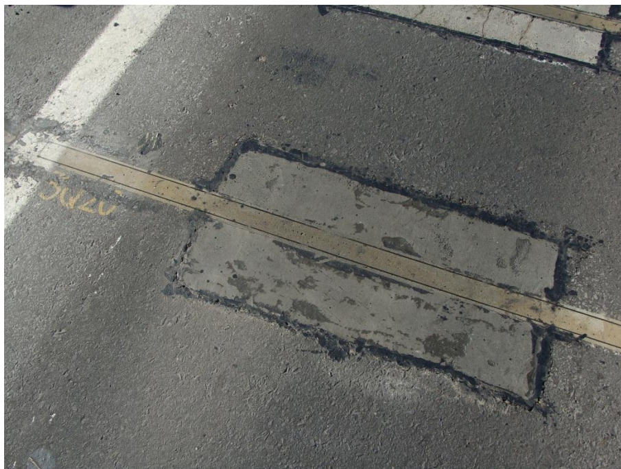
Figura 42 - Aspecto final da abertura 3Q20 após 30 dias de tráfego.
