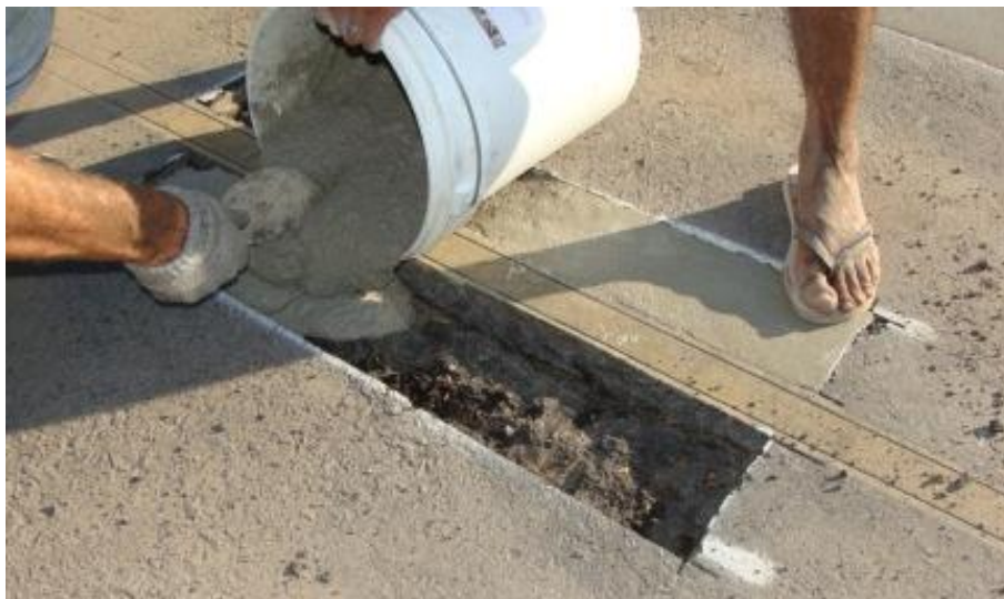
Figura 16 - Aplicação do GROUTTEK LFR 1 BRANCO.
