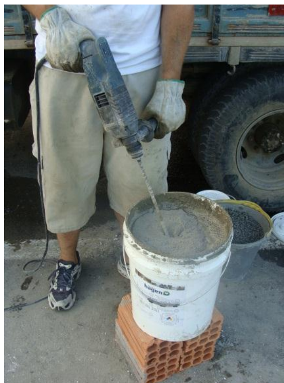
Figura 30 - Mistura do GROUTEK AN.
