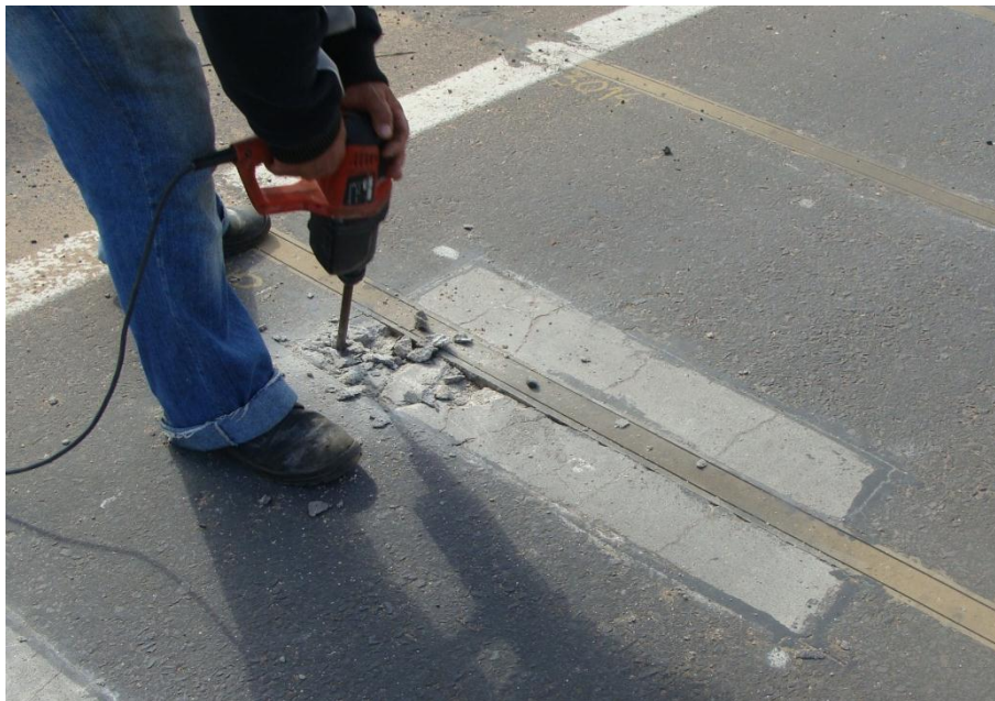
Figura 59 - Retirada do graute danificado.
