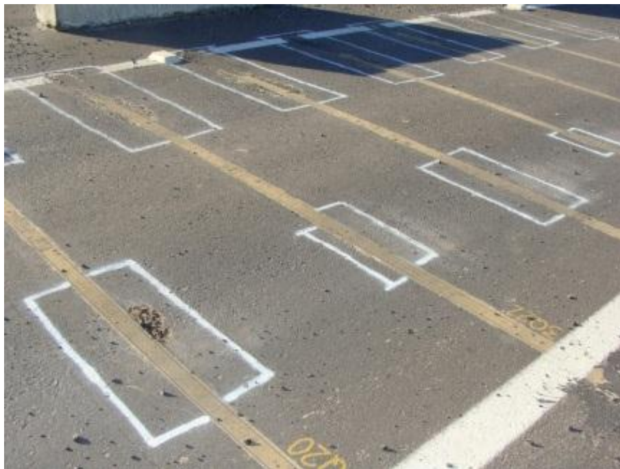
Figura 8 - Demarcações dos dezoito sensores para corte.
