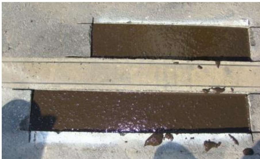
Figura 24 - Auto-adensamento do HAGENHARD GROUT.
