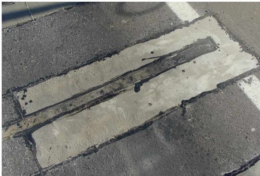
Figura 54 - Aspecto final da abertura 3Q25 após 30 dias de tráfego.
