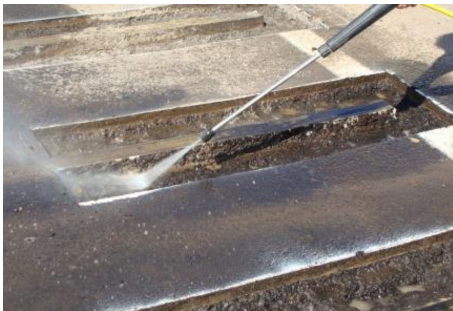
Figura 14 - Limpeza da abertura para aplicação do graute.
