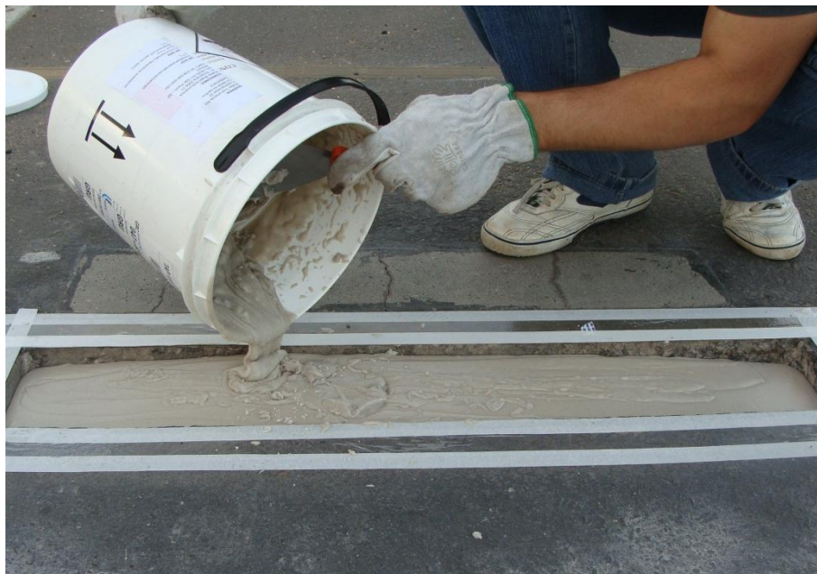
Figura 63 - Aplicação da resina RESIMIX.
