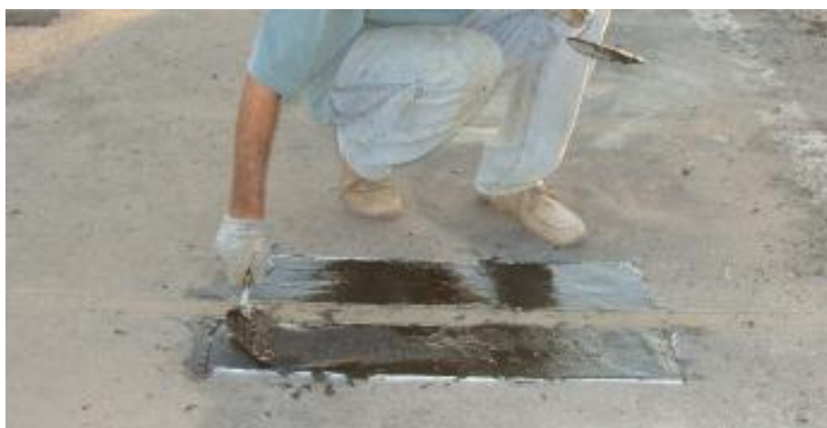
Figura 25 - Acabamento do HAGENHARD GROUT.
