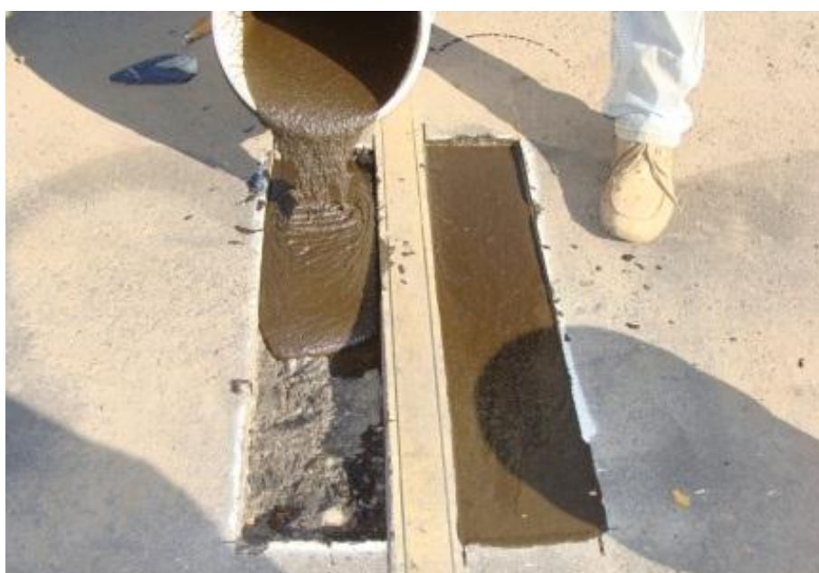
Figura 23 - Preenchimento com HAGENHARD GROUT.
