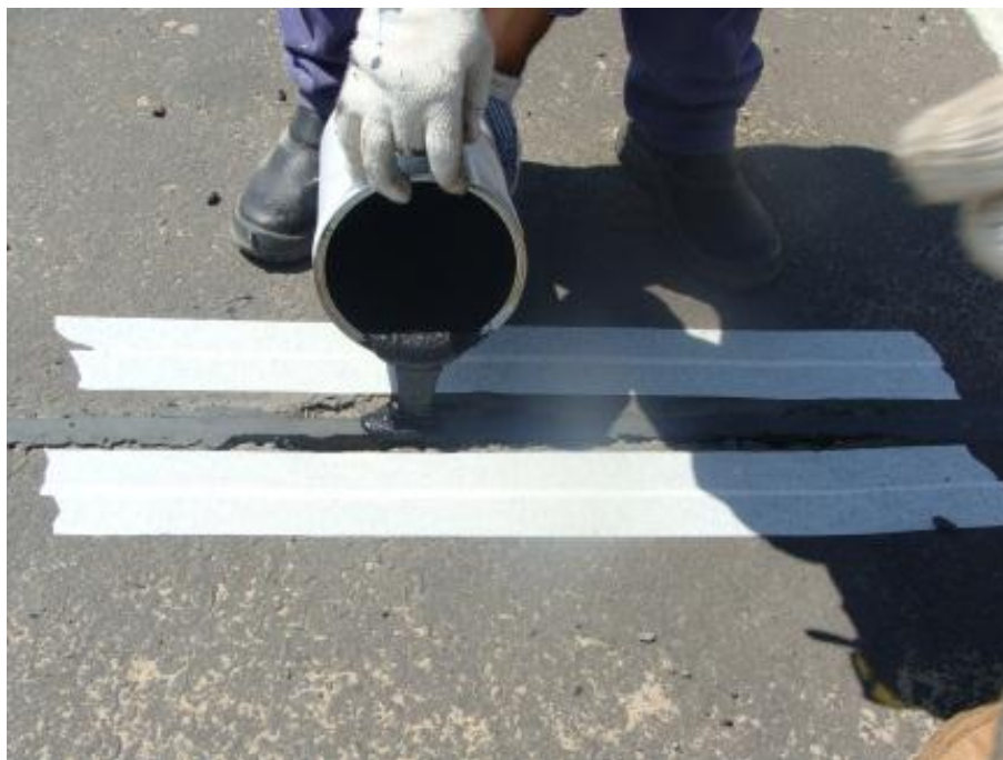
Figura 85 - Aplicação do graute nos sensores óticos.
