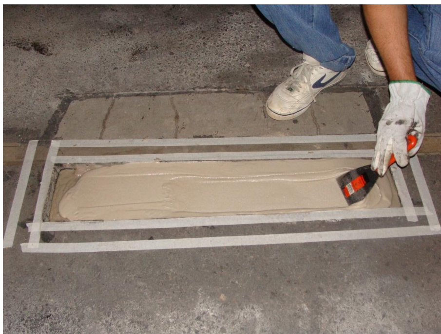
Figura 64 - Espalhamento da resina.
