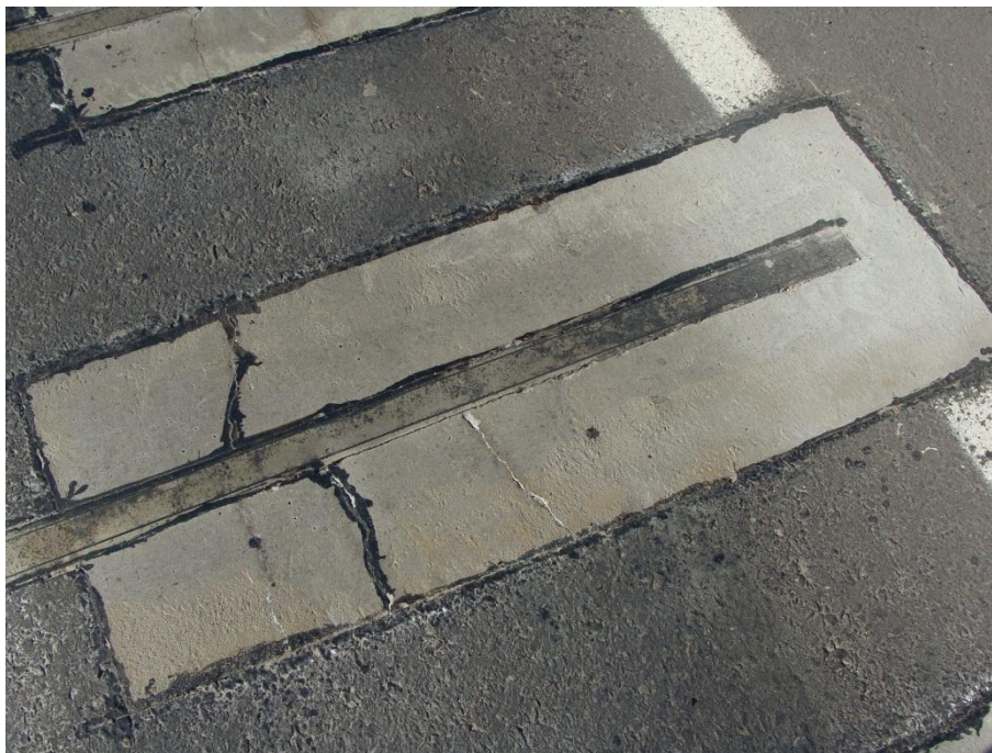
Figura 52 - Aspecto final da abertura 3Q21 após 30 dias de tráfego.
