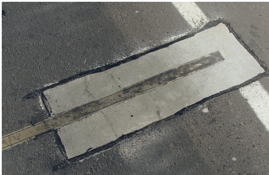
Figura 48 - Aspecto final da abertura 3Q13 após 30 dias de tráfego.
