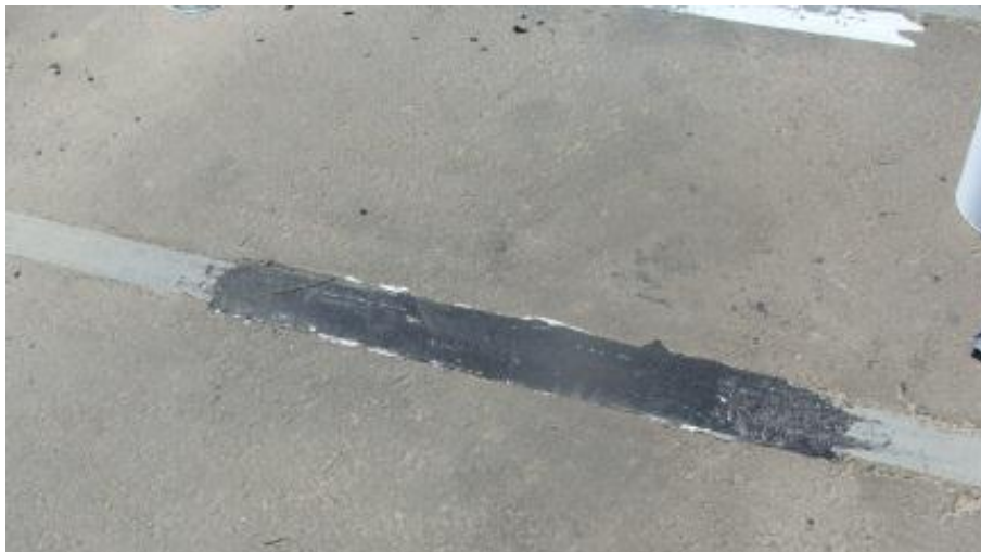
Figura 78 - Aspecto final da restauração dos sensores cerâmicos.
