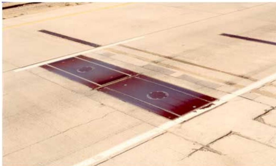
Figura 9 – Sistema WIM com célula de carga
