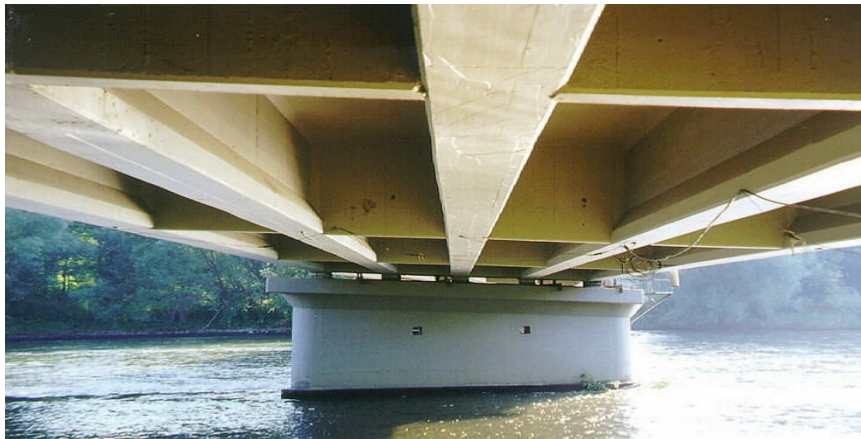
Figura 8 – Sistema WIM para pontes
