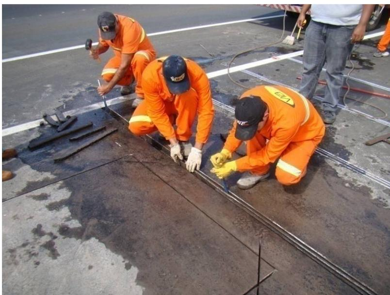
Figura 40 – Remoção do material das aberturas de cada sensor.
