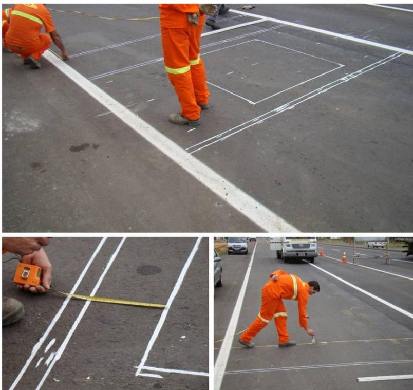
Figura 37 – Marcação dos sensores Hestia ECM.
