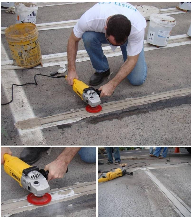
Figura 29 – Acabamento da superfície de contato entre a carga e o sensor.
