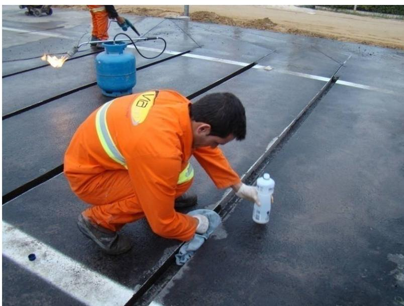
Figura 16 – Limpeza dos resíduos de material e secagem.
