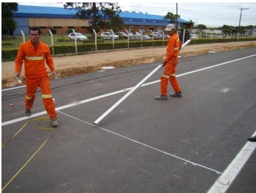
Figura 10 – Marcação com tinta branca para piso.
