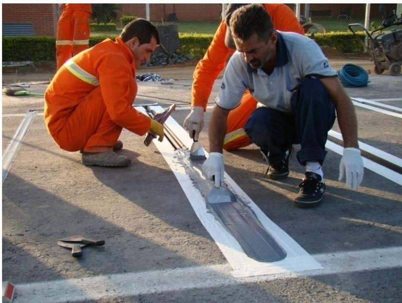
Figura 50 – Encobrimento do sensor por segunda camada de resina.
