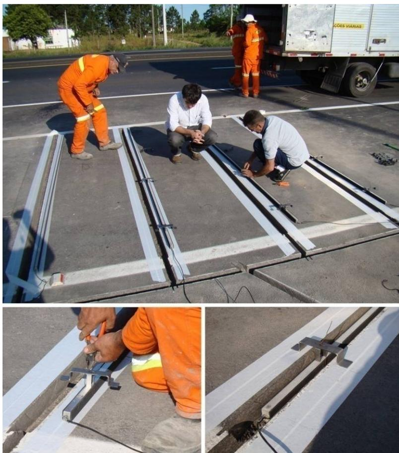
Figura 45 – Posicionamento do sensor no interior da abertura.
