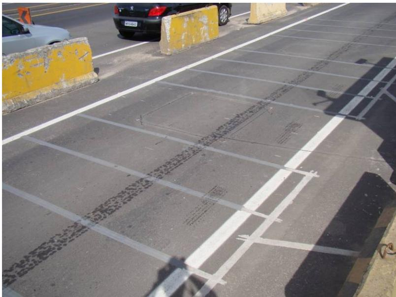
Figura 52 – Sensores de pesagem em movimento ECM (cerâmico).
