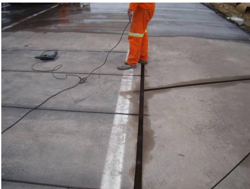
Figura 62 – Canaletas de passagem de cabos.
