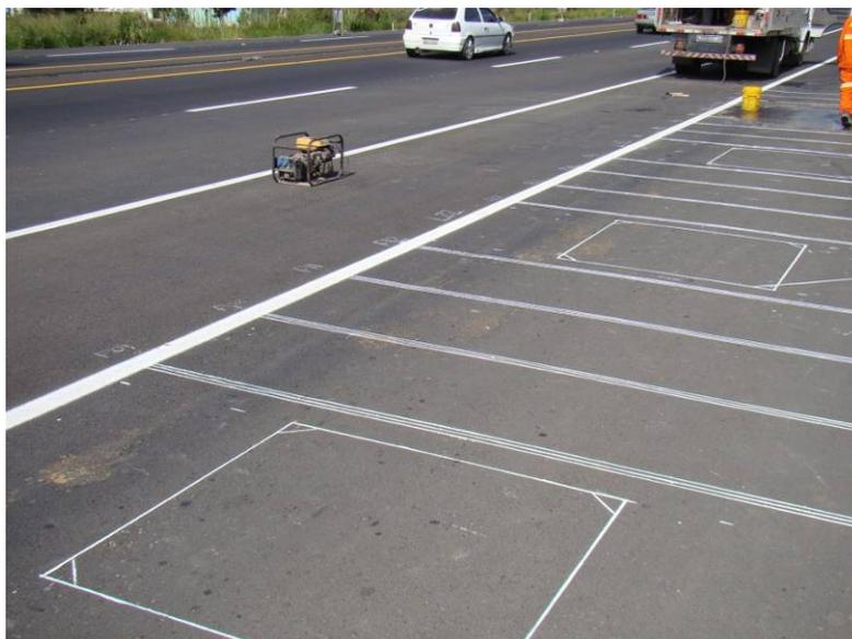
Figura 83 – Marcação e pinturas das aberturas do sensor Laço.
