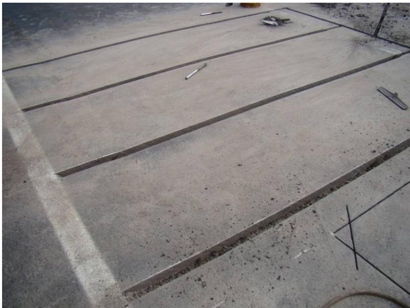
Figura 41 – Limpeza e remoção de material de quatro aberturas do sensores Hestia ECM.
