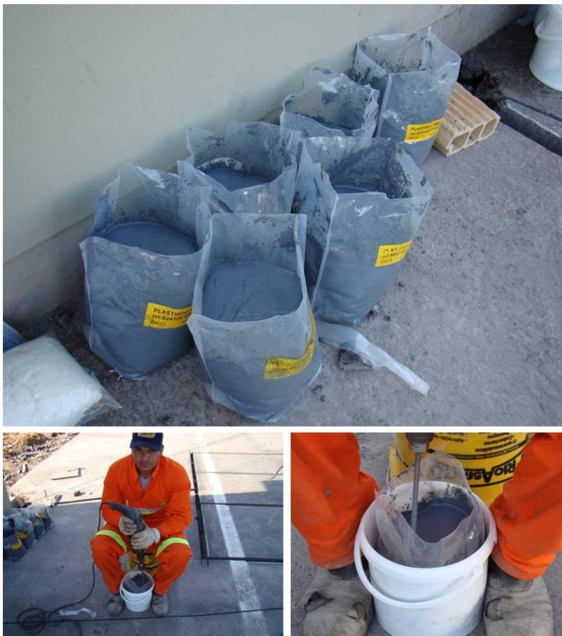
Figura 47 – Etapas da mistura da resina epóxi (grout).
