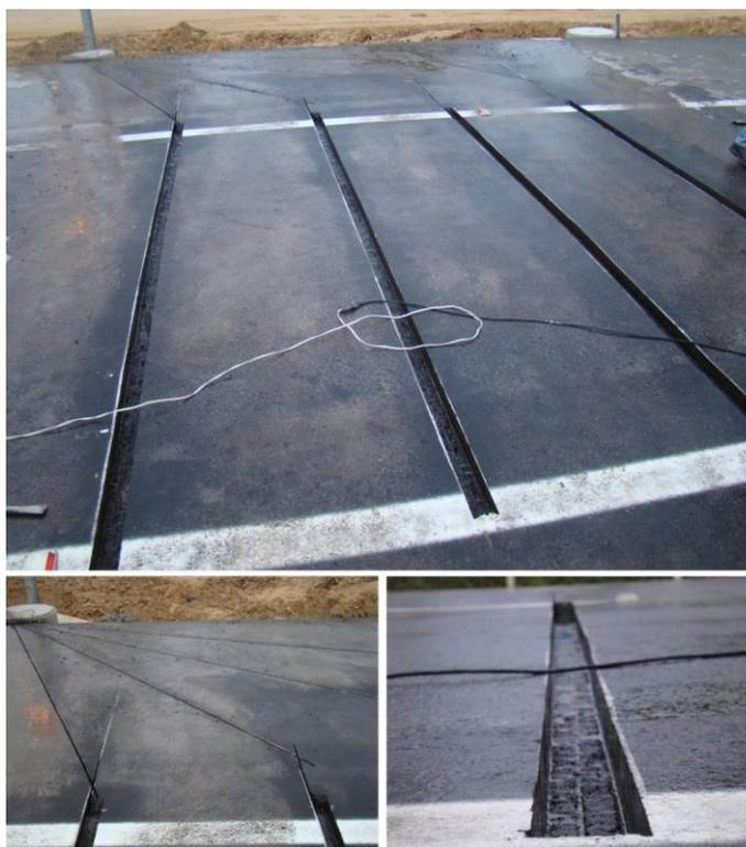
Figura 15 – Aberturas após corte e remoção do material betuminoso.
