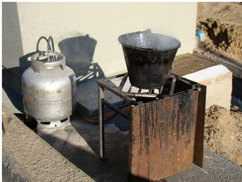
Figura 87 – Aquecimento do ligante asfáltico.
