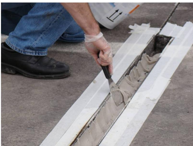
Figura 26 – Preenchimento primário da abertura com resina para acomodação de sensor.
