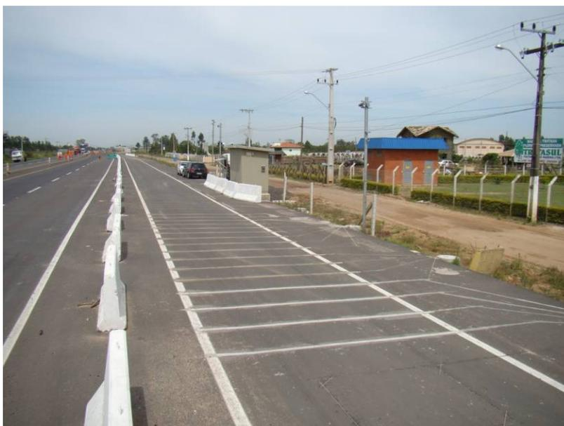
Figura 30 – Sensores de pesagem em movimento com sensores piezelétrico quartzo.
