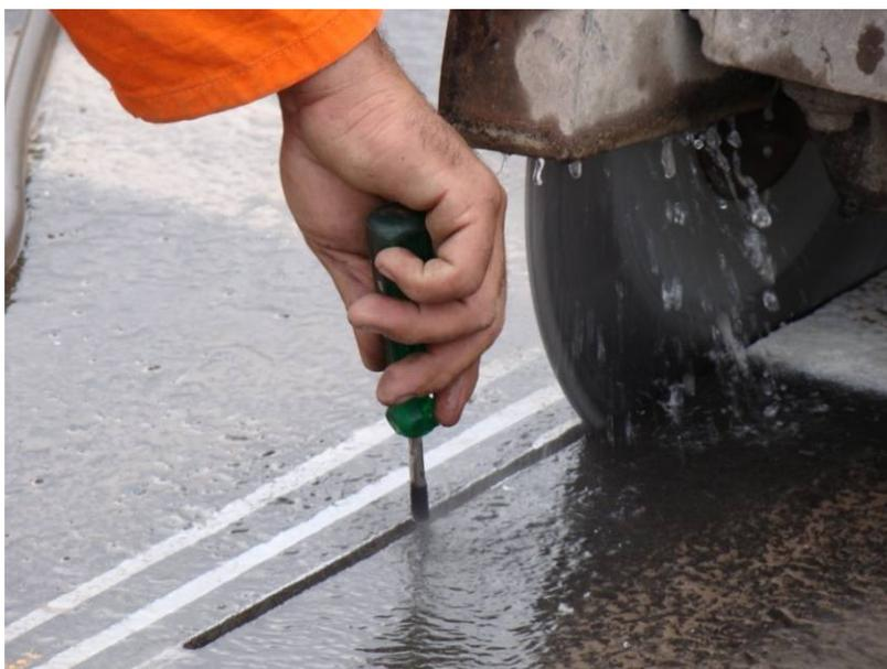
Figura 13 – Checagem da profundidade de corte.
