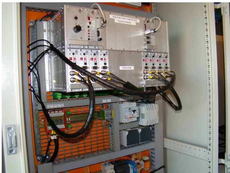
Figura 36 – Equipamentos de aquisição dos sinais dos sensores.
