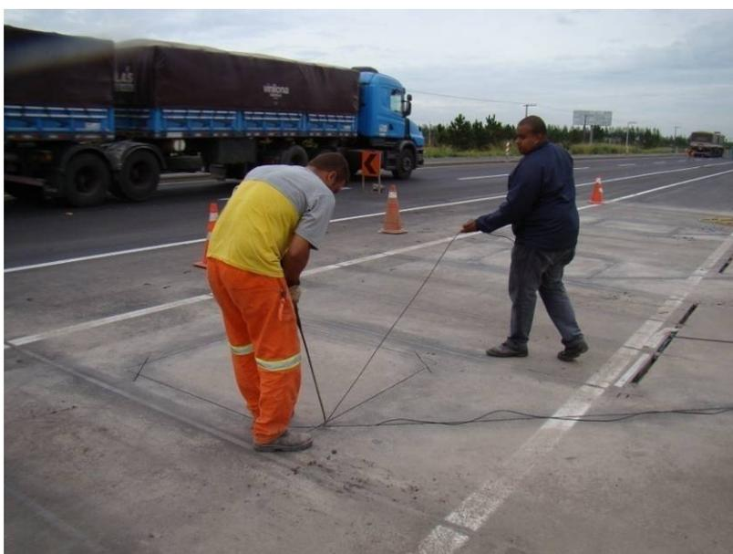
Figura 86 – Posicionamento do cabo sensor de laço indutivo.
