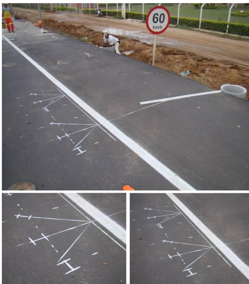
Figura 74 – Disposição de corte e alinhamento dos sensores.
