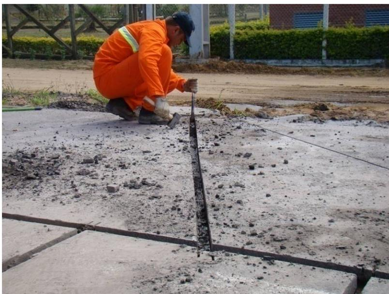
Figura 42 – Limpeza das aberturas para passagem dos cabos dos sensores.
