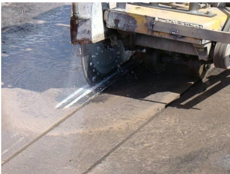
Figura 39 – O corte de cada abertura é realizado em três etapas.
