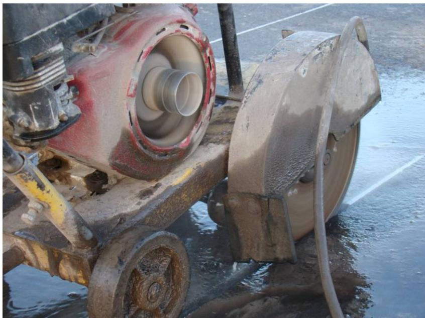
Figura 60 – Corte das aberturas com serra (20 x 25 mm).
