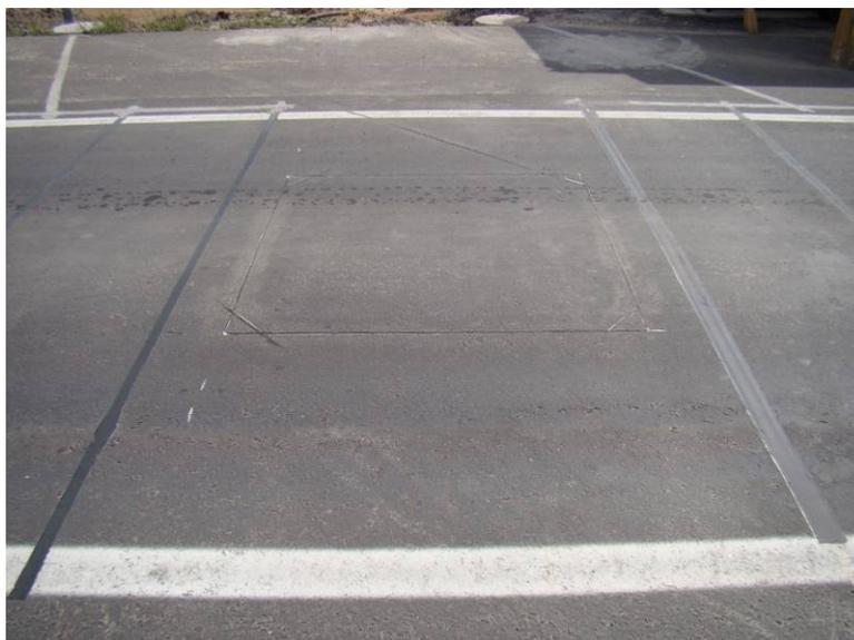
Figura 90 – Laço instalado entre os sensores Hestia e BL (Laço 6).
