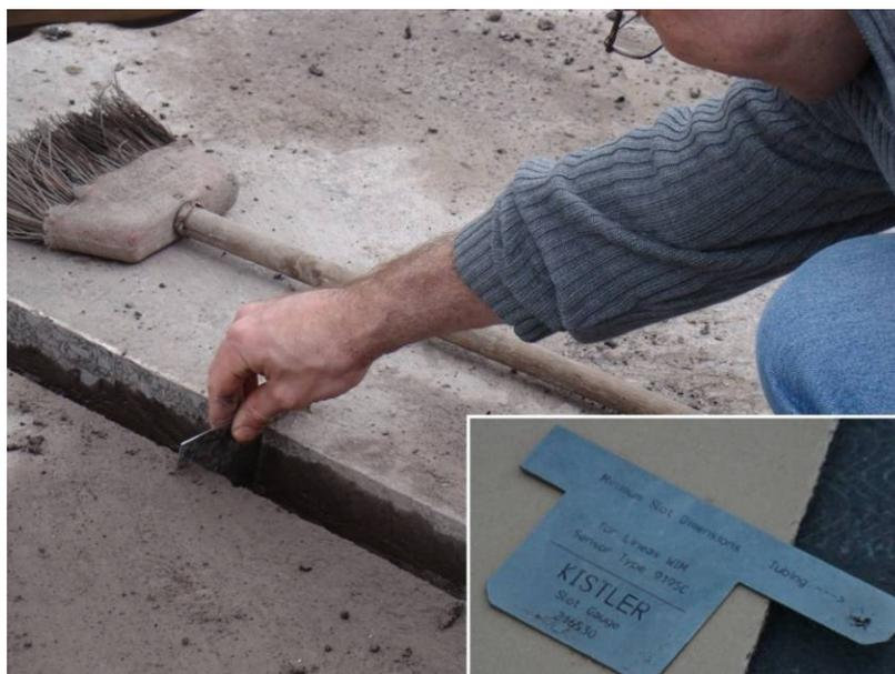
Figura 14 – Verificação das dimensões da abertura com gabarito Kistler de instalação.
