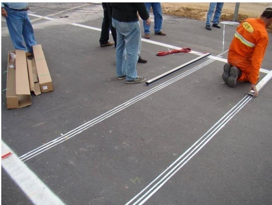
Figura 11 – Alinhamento dos sensores e espaçamento das aberturas.
