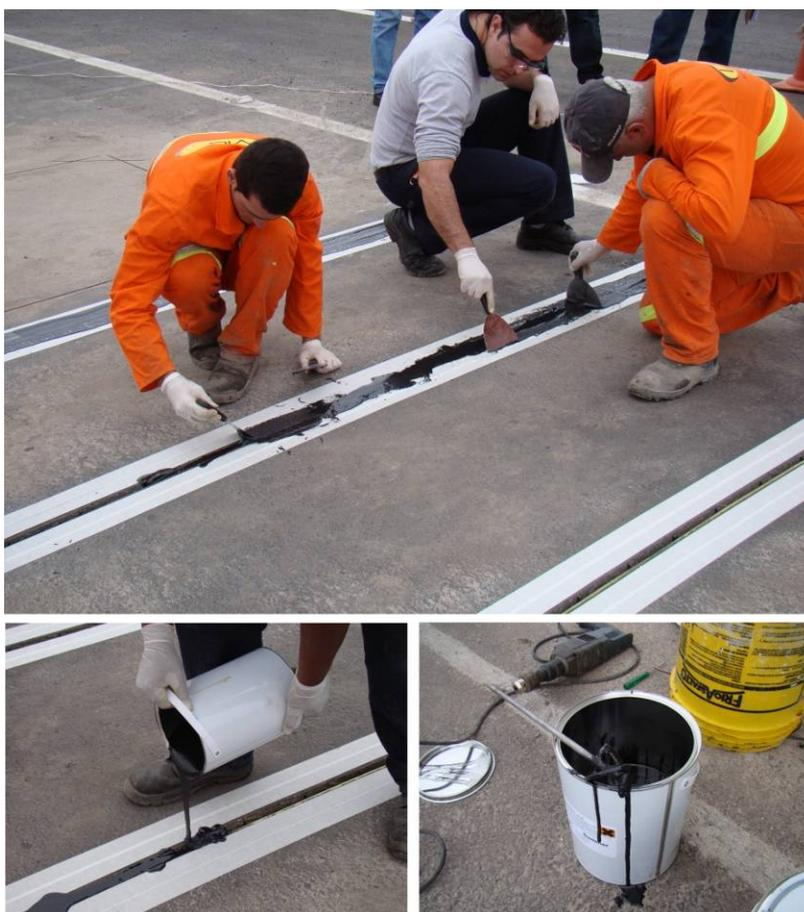
Figura 70– Espalhamento da superfície da resina do interior da abertura.
