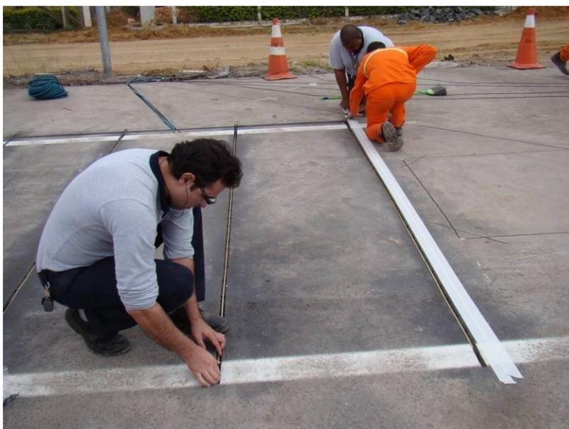
Figura 68 – Posicionamento do sensor e colocação de fita crepe.
