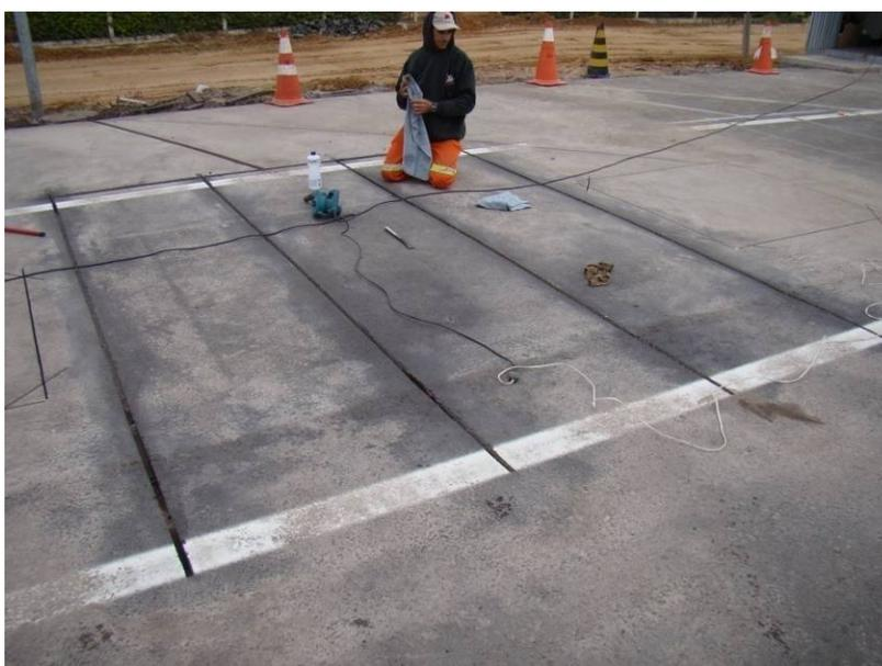
Figura 63 – Limpeza das aberturas com álcool.
