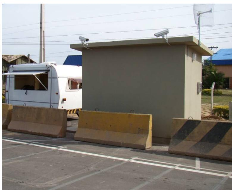
Figura 92 – Câmeras de registro de placas dianteira e traseira.
