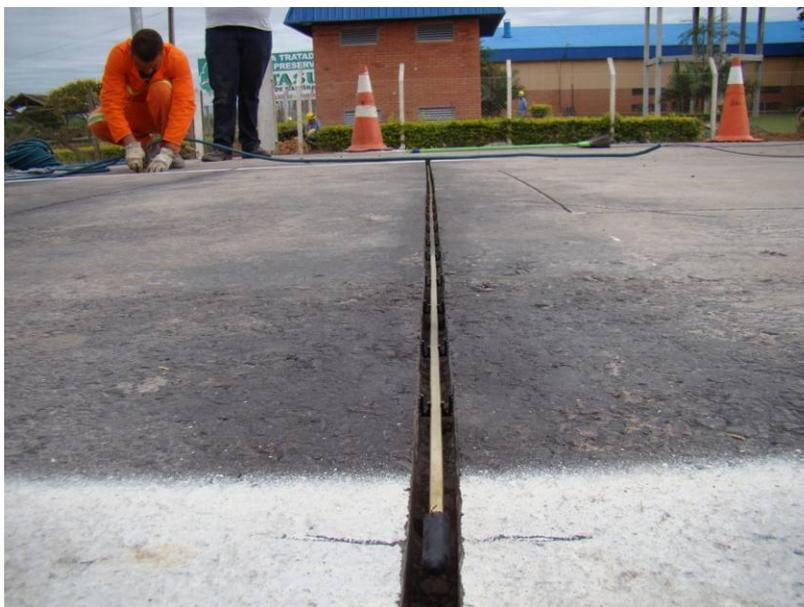
Figura 67 – Posicionamento no interior da abertura com espaçadores.
