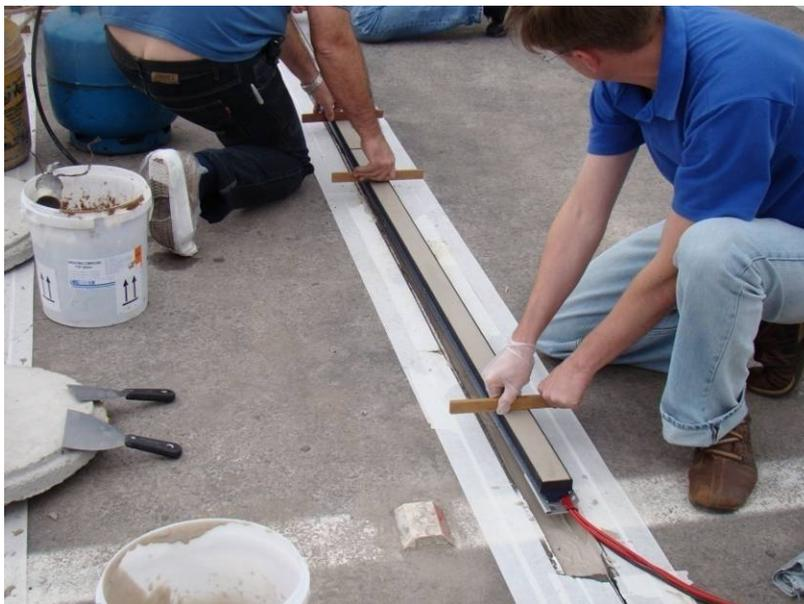
Figura 27 – Acomodação do sensor dentro da abertura com primeira cada de resina.
