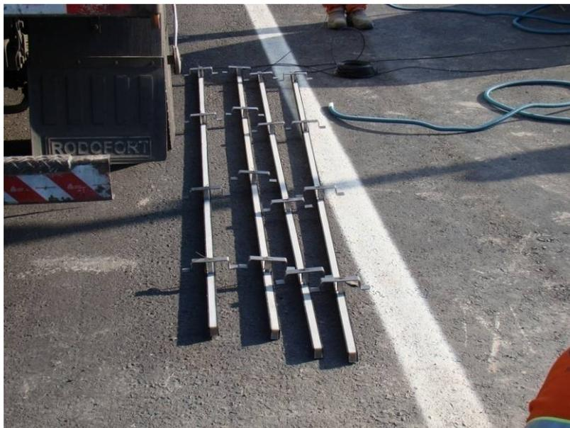
Figura 44 – Sensores ECM piezo elétrico de base cerâmico.
