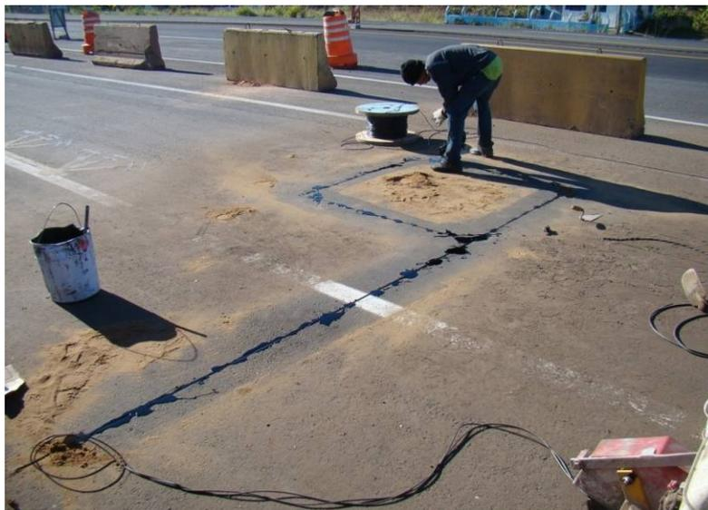
Figura 89 – Acabamento final do sensor de presença (Laço 1).
