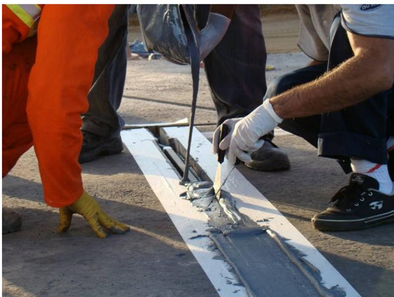
Figura 51 – Despejo e espalhamento da resina sobre abertura com sensor.
