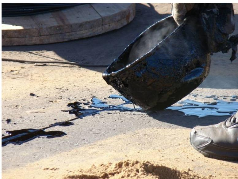
Figura 88 – Aplicação de ligante asfáltico.
