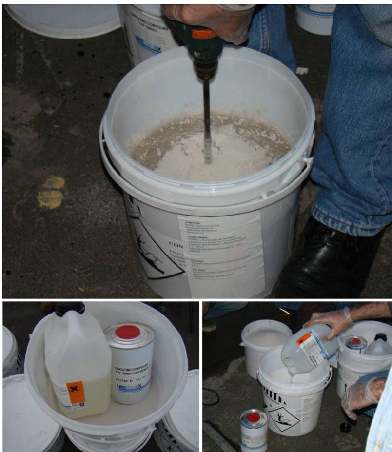
Figura 24 – Embalagem dos materiais componentes do “grout” e mistura com bateadeira.
