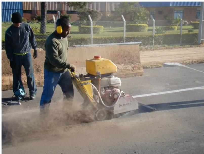
Figura 84 – Corte das aberturas com serra circular.
