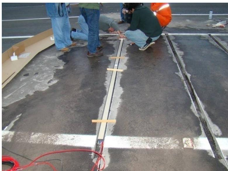
Figura 22 – Ajuste quanto ao posicionamento do sensor dentro da abertura.
