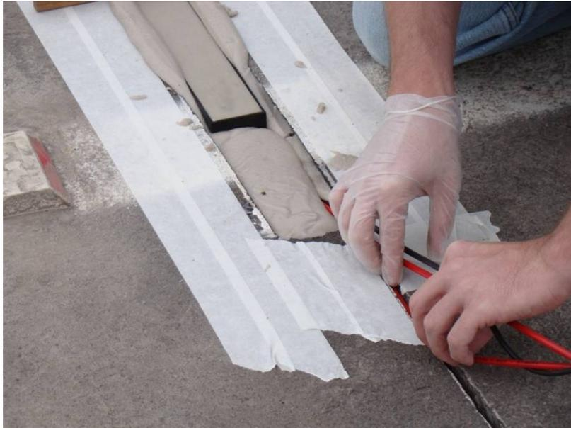
Figura 28 – Acomodação dos cabos de conexão (sensor quartzo).
