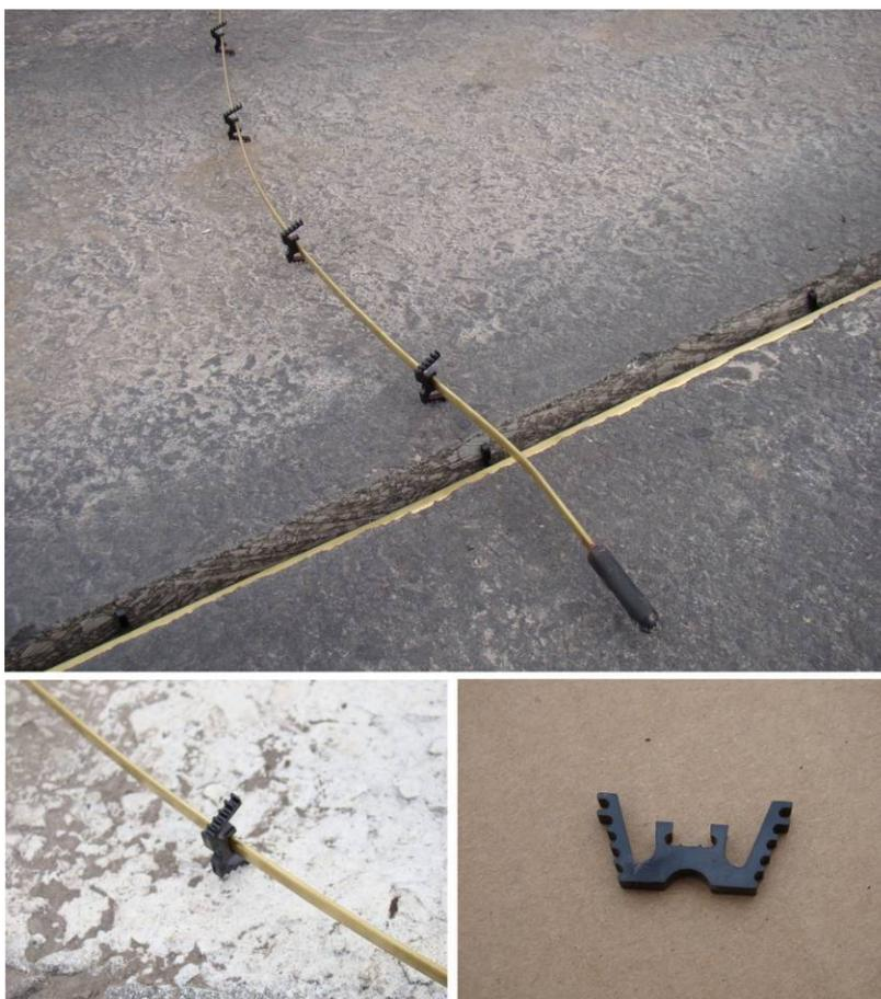
Figura 65 – Fixação dos espaçadores na linha de sensor.
