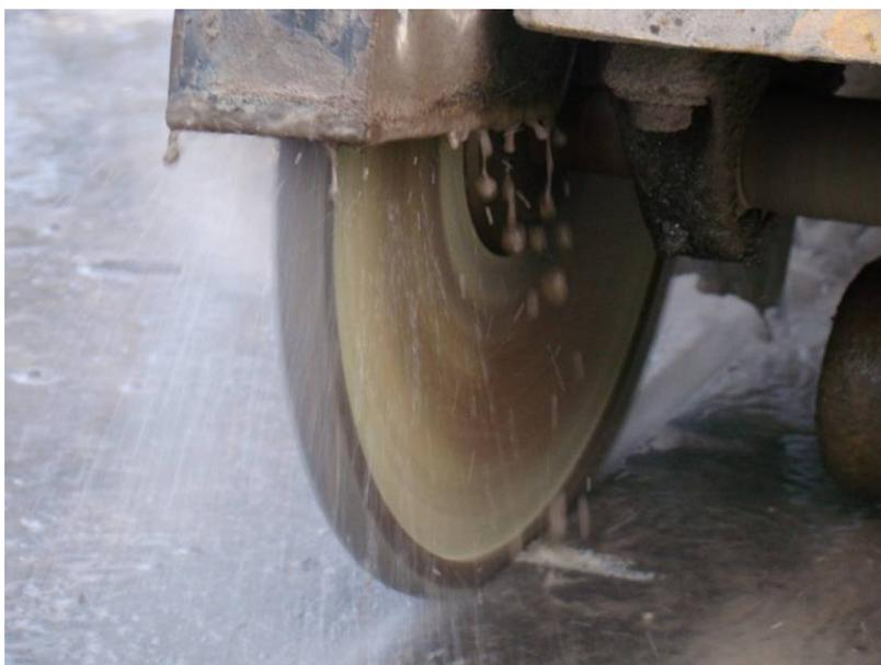
Figura 75 – Corte das aberturas dos sensores com serra de espessura 20 mm.
