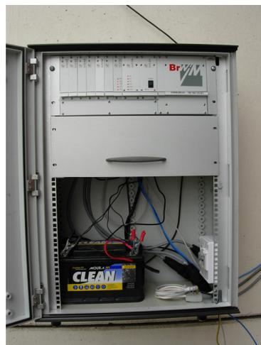
Figura 13 – Eletrônica local do sistema SiWIM, sob uma ponte
