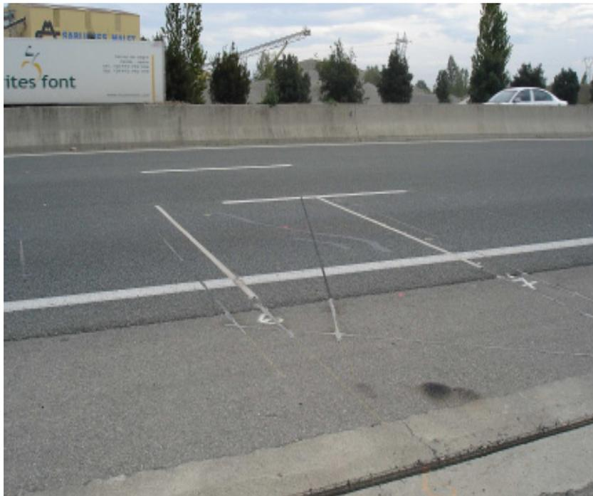
Figura 47 – Sensores piezos-cerâmicos (2) do HS-WIM
