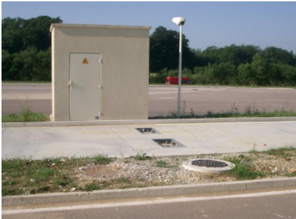
Figura 61 – Berços dos sensores e abrigo da eletrônica local
