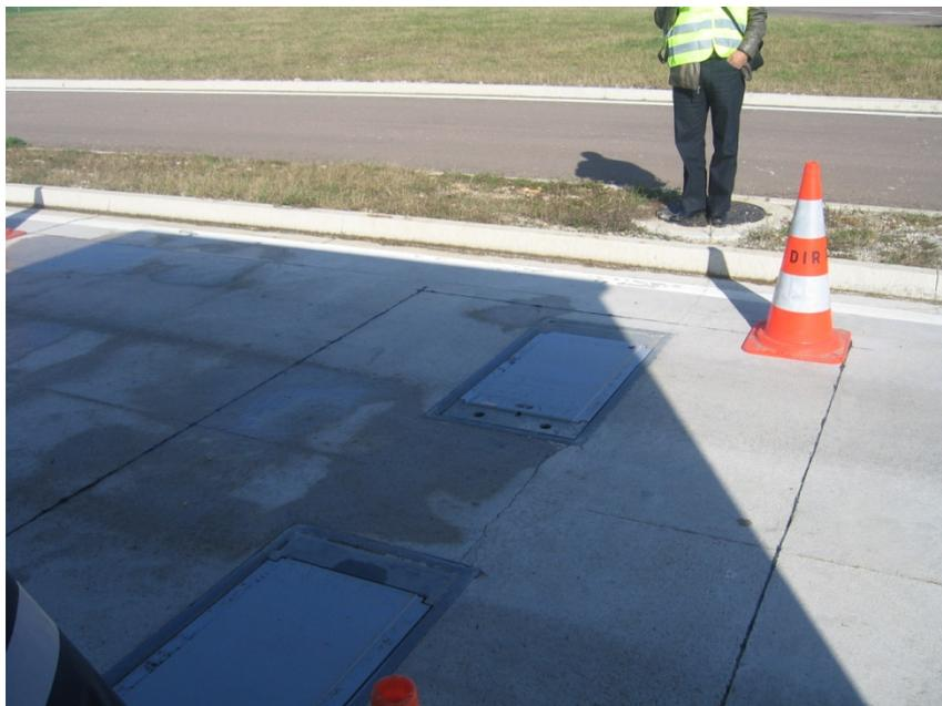
Figura 64 – Sensores tipo *load cell* instalados nos berços
