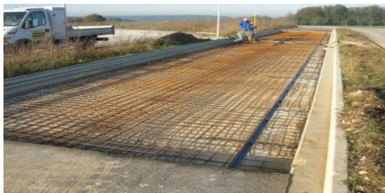
Figura 58 – Estrutura de pista para pesagem em LS-WIM
