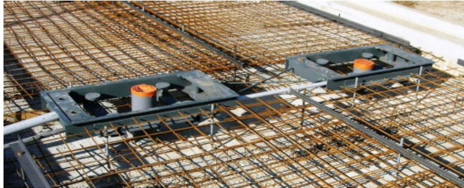
Figura 59 – Berços dos sensores tipo *load cell* usados
