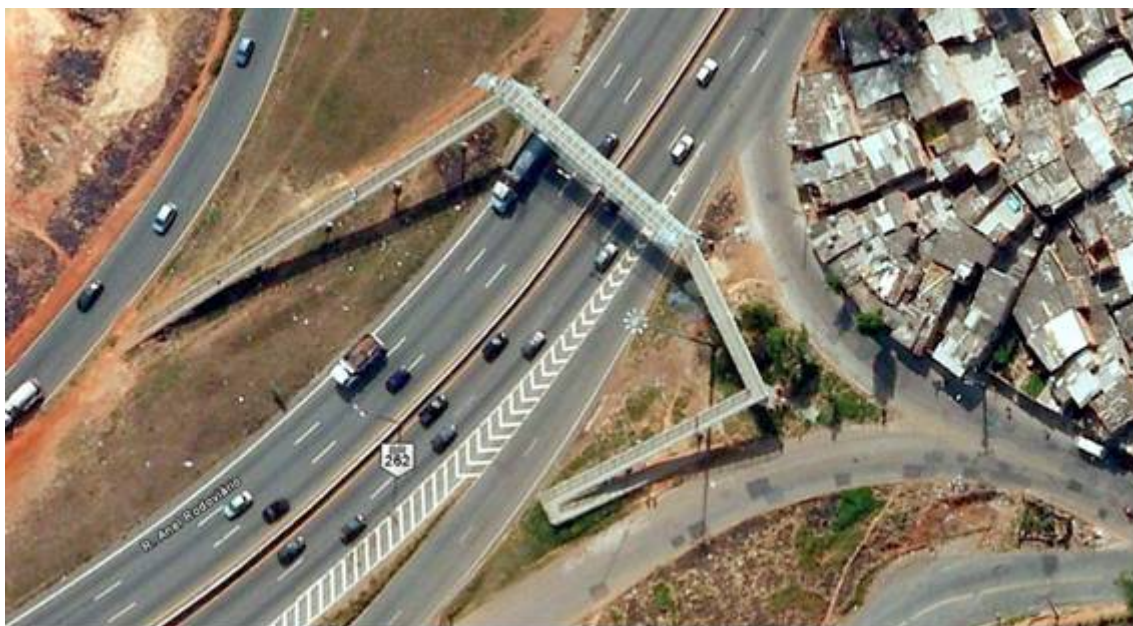
Figura 25. Passarela implantada no km 19
