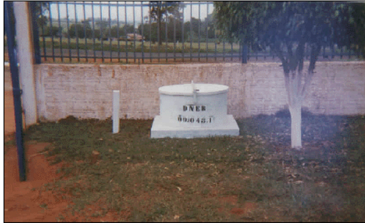
Figura 2: Abrigo dos Postos de Contagem Fonte: DNIT (2006)
