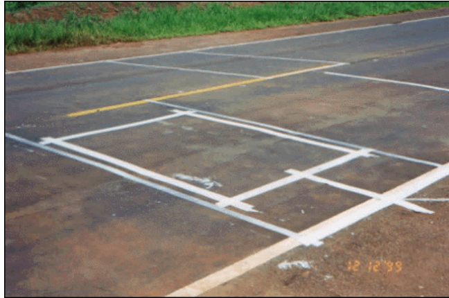
Figura 4: Loops dos Postos de Contagem Fonte DNIT(2006)
