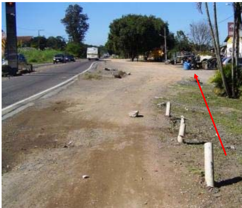
Figura 7 Vestígio do Acidente (Muretas de concreto danificadas)
