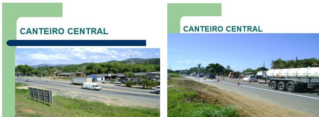
Figura 27 Canteiro Central no Km 62 da BR-470 - antes e depois das obras do DNIT
